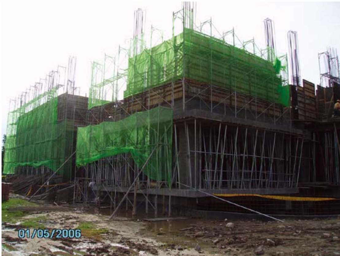
照片 3.2.3.4 調度中心施工正面圖
