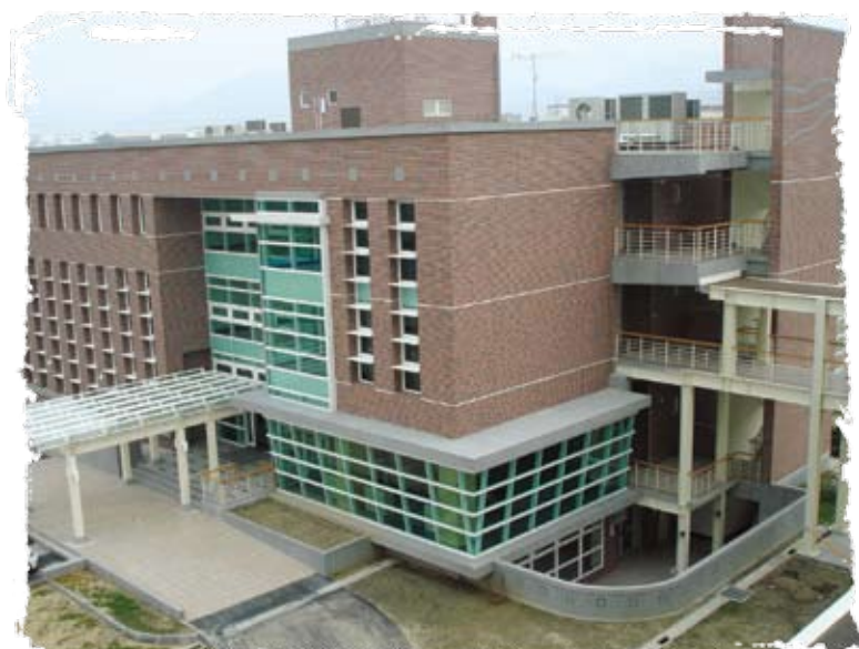
本局「中區水資源局調度中心新建工程」 完工(95.12.4)
