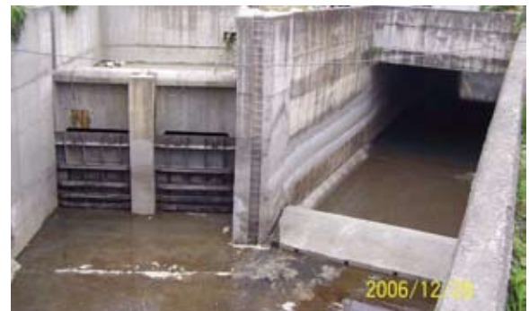
照片 3.2.5.4 尾水閘門現況
