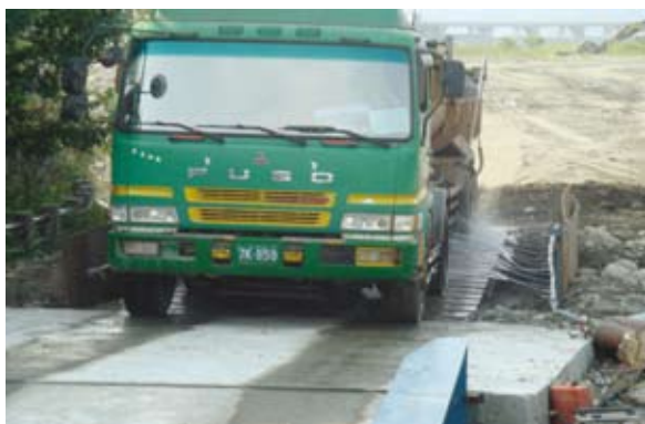
地磅檢測照片 6-2-5
