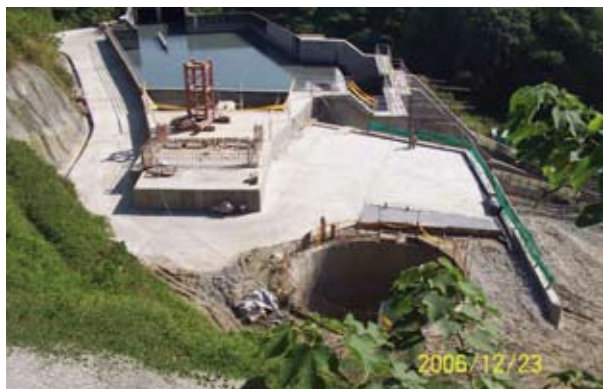
照片 3.2.5.5 進水口現況
