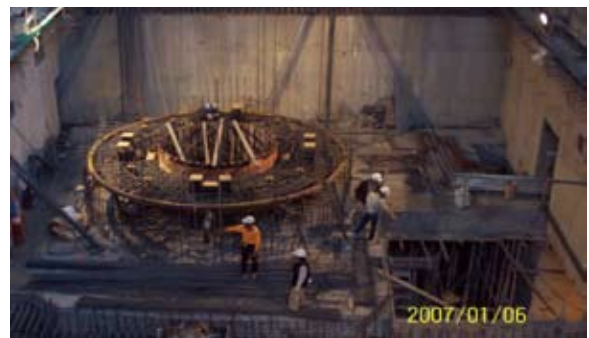
照片 3.2.5.2 2號機 EL158.77 組筋
