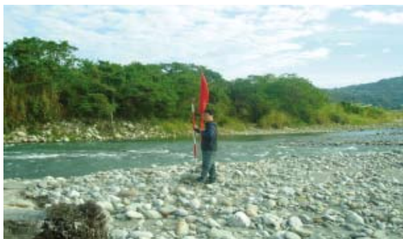
清淤施工照片 6-2-1
