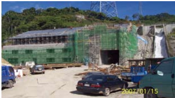
照片 3.2.5.1 廠房現況
