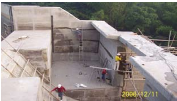
照片 3.2.5.3 溢流堰修補
