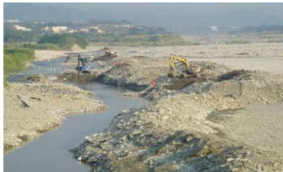
清淤施工照片 6-2-2
