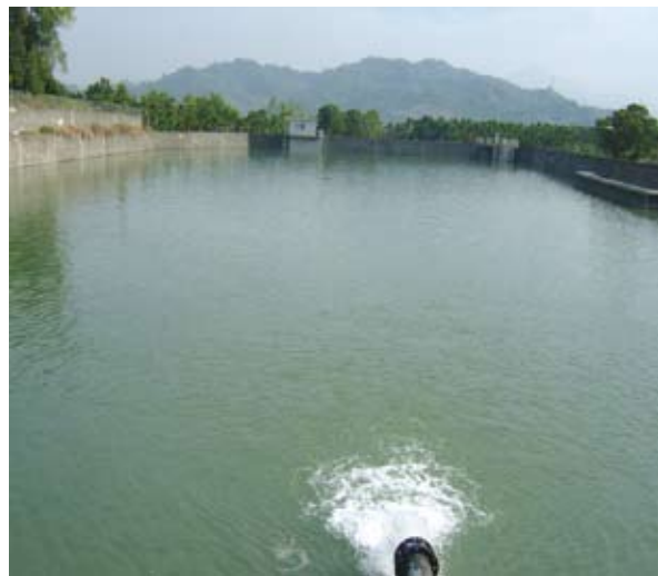
照片 3.2.1.2 第一號貯水池（蓄水）
