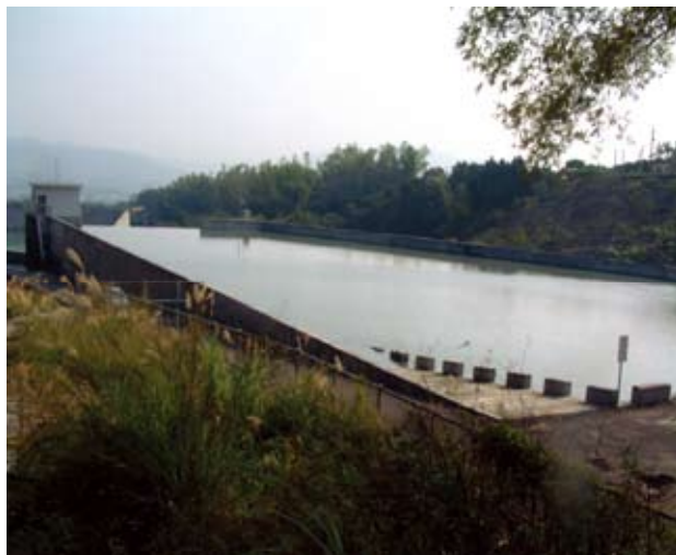
照片 3.2.1.5 第四號貯水池（蓄水）
