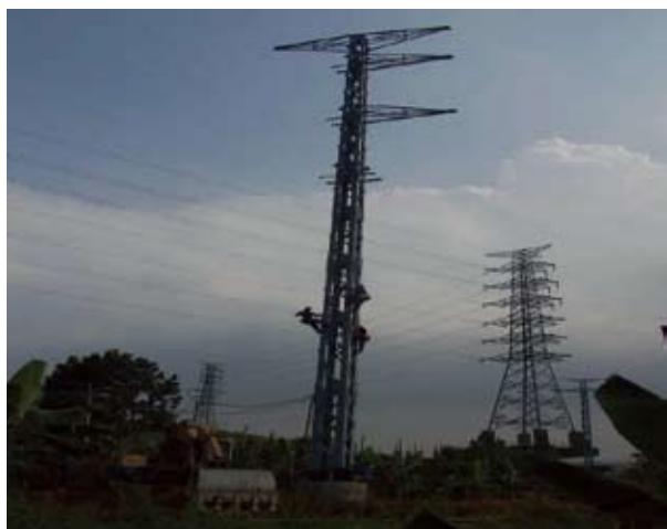
照片 3.2.5.7 輸配電鐵塔安裝完
