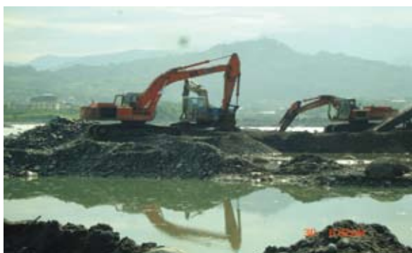
清淤施工照片 6-2-3
