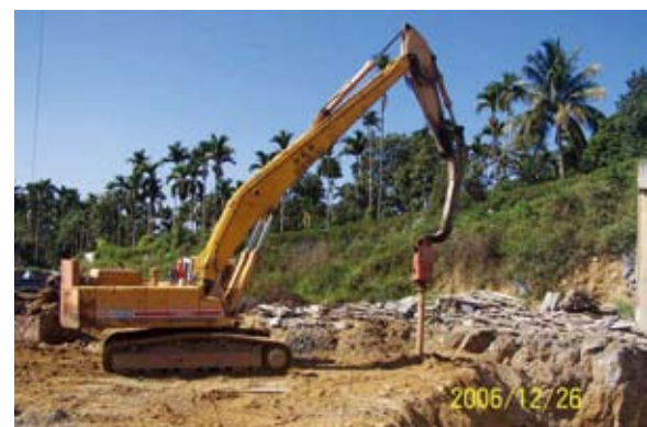
照片 3.2.5.6 尾水路中間柱鑽掘施
