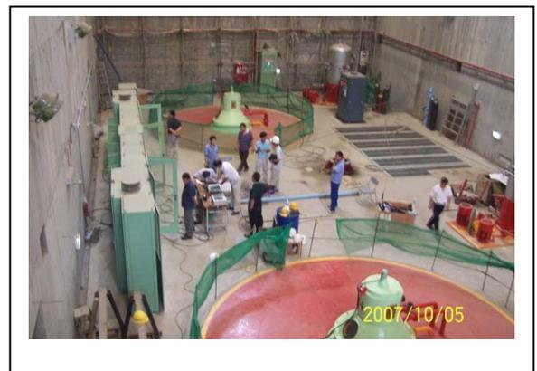
照片 3.2.4.8 發電機試運轉 168 小時
