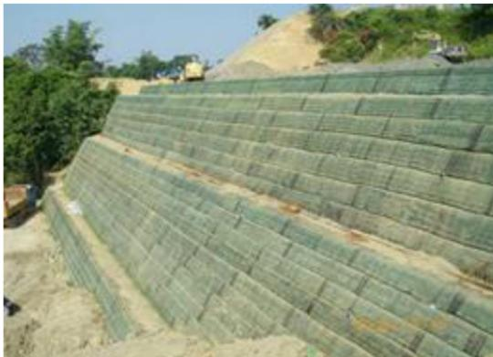
照片 3-2-26 左岸遷建道路工程加勁擋土牆施工情形
