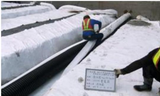
照片 3-2-22 溢洪道 NO.29、30 分塊 HDPE 管裝設情形
