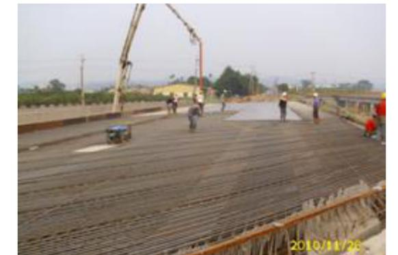
照片 3-2-17 梅林橋橋面版混凝土澆置情形
