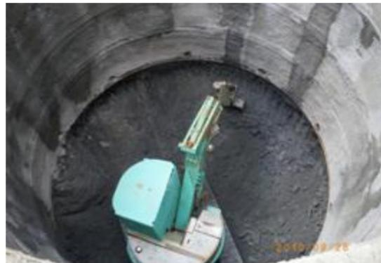
照片 3-2-25 左遷道路二號橋井式基礎施工情形
