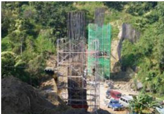
照片 3-2-24 左遷道路二號橋橋墩柱鋼筋組立情形
