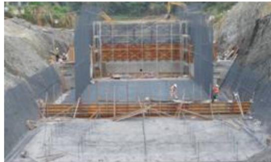
照片 3-2-23 溢洪道 NO.29 分塊混凝土澆置及 NO.30 鋼筋組立
