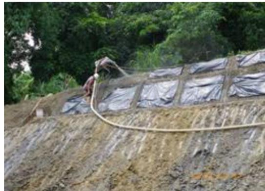
照片 3-2-27 左遷道路自由型格梁護坡施工情形
