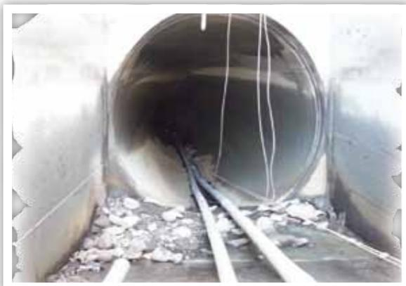
照片 9-1-3 集集攔河堰倒虹吸工抽水檢查
