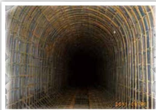
照片 11-2-13 溢洪道排水廊道襯砌前鋼筋組立完成情形
