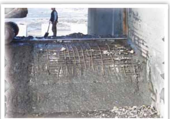
照片 9-1-2 集集攔河堰上游磨損情況
