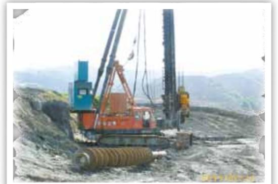
照片 11-2-14 取水工第二平台擋土排樁鑽掘情形
