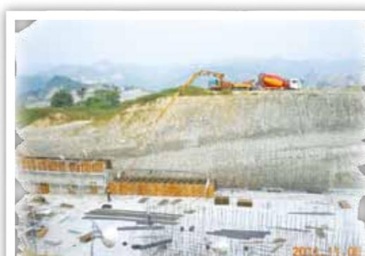
照片 11-2-12 溢洪道 NO.11 牆體升層施工情形
