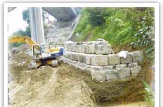
照片 11-2-16 左邊道路二號橋邊坡保護工施作情形
