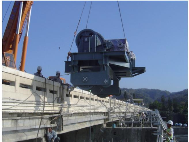
照片 3-5-4 溢洪道弧形閘門吊門機安裝
