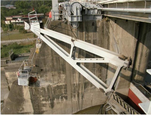
照片 3-5-1 溢洪道弧形閘門拆除
