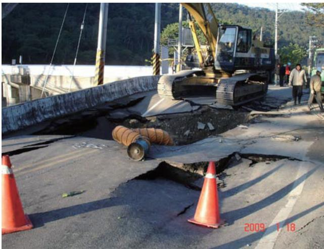
照片 10-1-1 破管事件造成苗 52 線路面產生坑洞
