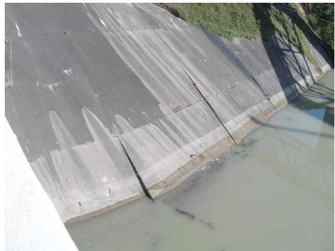
照片 10-1-2 破管事件造成後池堰邊坡混凝土面板錯動
