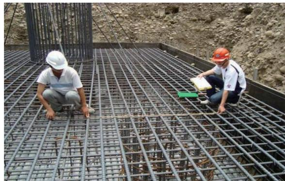
照片 3-2-12 橋墩鋼筋尺寸抽查
