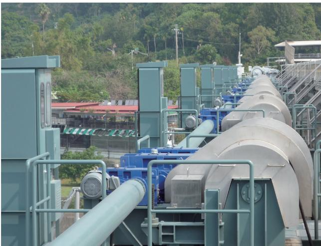
照片 3-5-5 溢洪道 8 ~ 15 號吊門機完成
