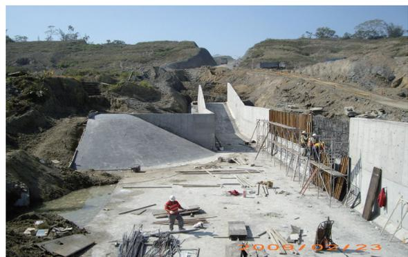
照片 3-2-8 導水明渠匯流段一側牆施作
