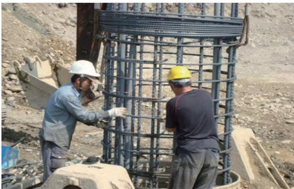
照片 3-2-11 全套管鋼筋籠吊放
