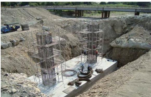
照片 3-2-13 橋墩柱鋼筋組立
