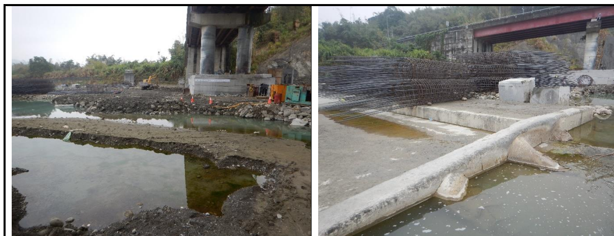
圖 2.5-20 桶頭固床工上游橋墩維修工程現場照片
