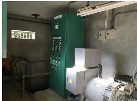
圖 3-3 滲漏室 ATS 開關箱及分電盤含抽水機開關箱製作更新流程圖
