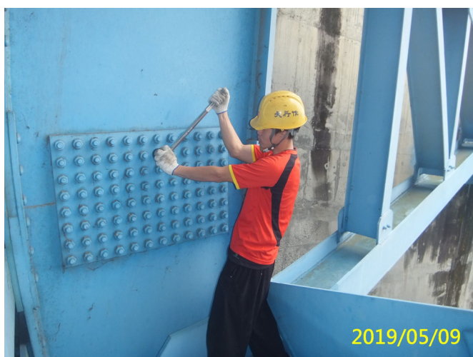
27. 108/5/9 溢洪道門體各螺栓檢查是否鬆脫及鎖緊
