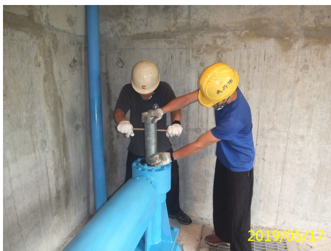
29. 108/5/17 南岸沉砂池排砂閘門吊門機銅套固定環鎖緊固定
