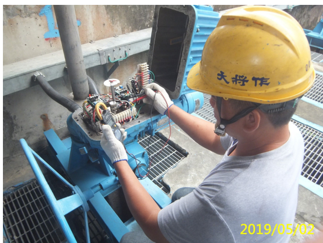
25. 108/5/2 魚道閘門吊門機驅動控制裝置定位極限開關功能檢測檢查
