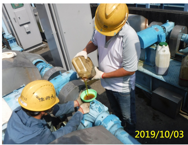
38. 108/10/3 南岸進水口上、下層閘門吊門機更換機油
