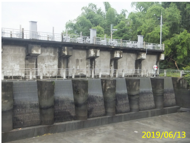
9. 108/6/13 北岸 3-3 段攔污柵垃圾阻塞清除作業後
