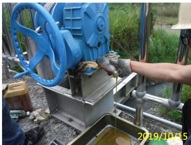
52. 108/10/15 十二甲自動閘門吊門機機油更換
