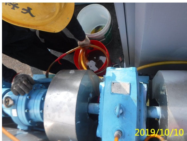
50. 108/10/10 北岸進水口上下層閘門更換機油中
