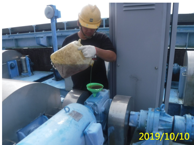
51. 108/10/10 北岸進水口閘門吊門機更換機油
