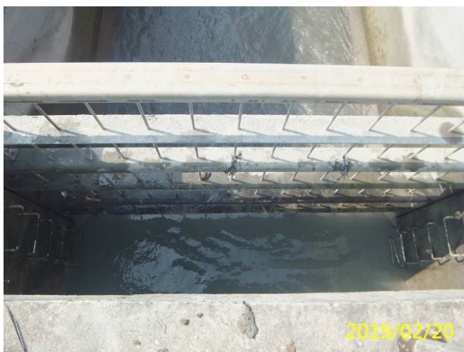
3. 108/2/20 南岸聯絡渠道攔污柵內垃圾阻塞清除後
