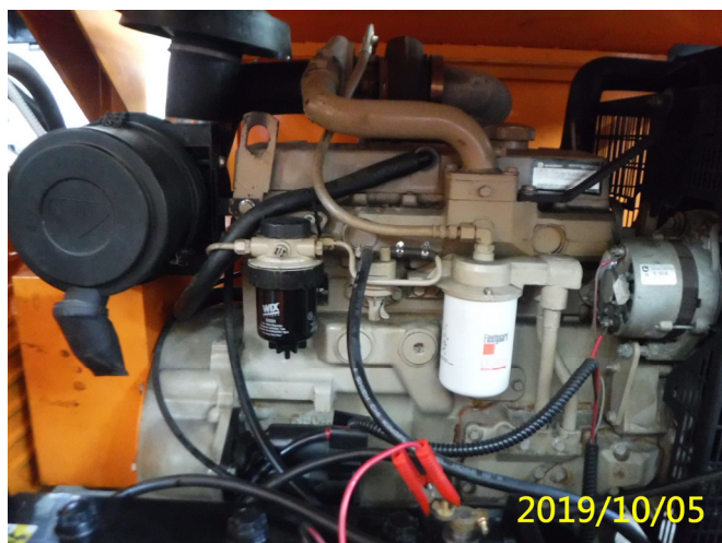
49. 108/10/5-0.3CMS 抽水機更換機油濾清器
