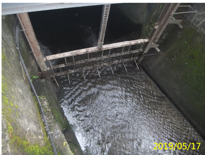
5. 108/5/17 集集大排攔污柵垃圾阻塞進行清除後
