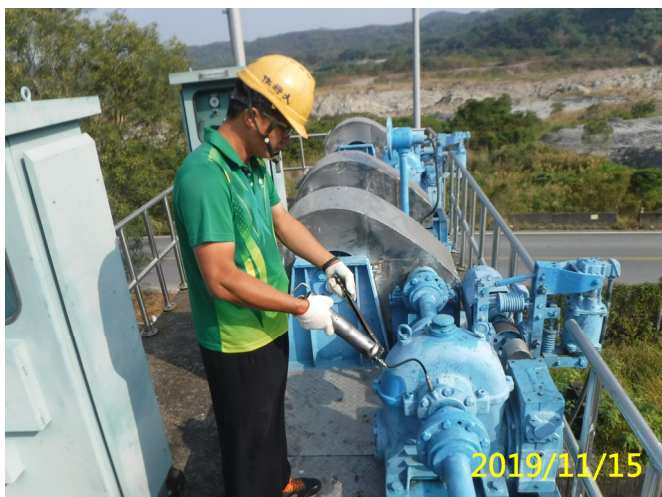
57. 108/11/15 南岸沉砂池分水閘門黃油更新 加注潤滑
