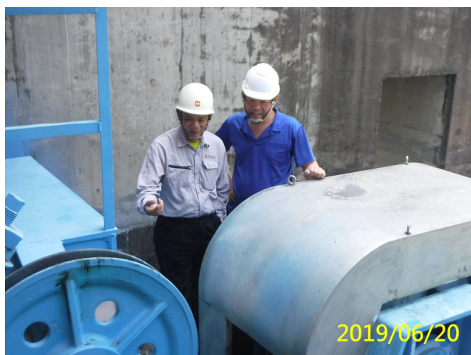
3. 108/6/20 機械技師至排砂道閘門執行技師業務
