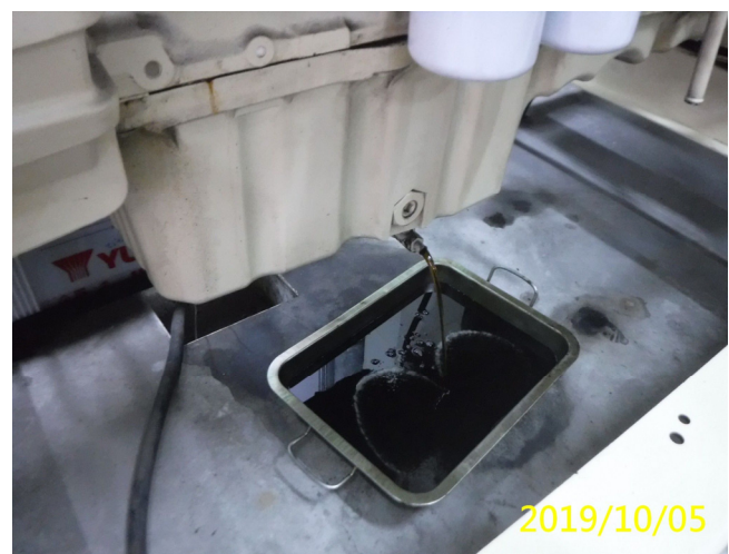
38. 108/10/3 南岸進水口上、下層閘門吊門機更換機油
