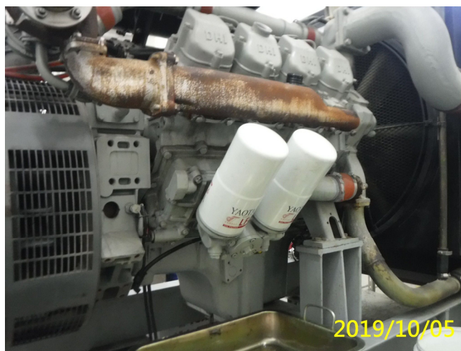
46. 108/10/5 集管中心大樓用 400kw 發電機換機油濾清器
