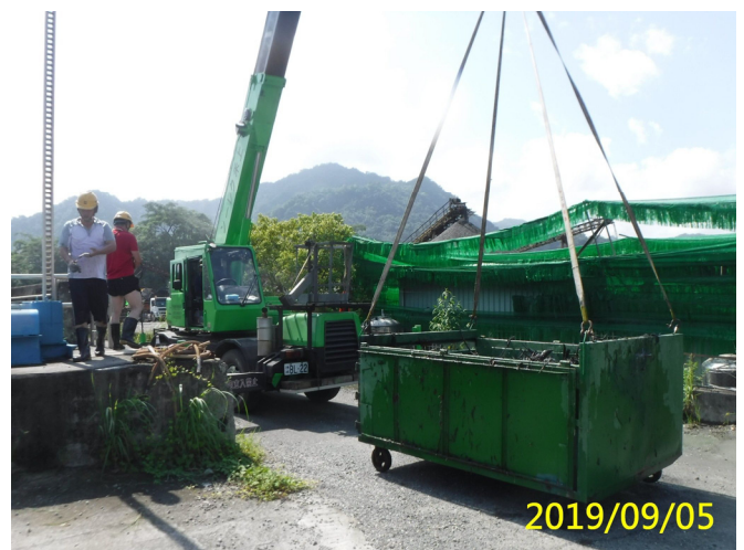
12. 108/9/5 南岸渠道攔污柵垃圾阻塞清除作業後
