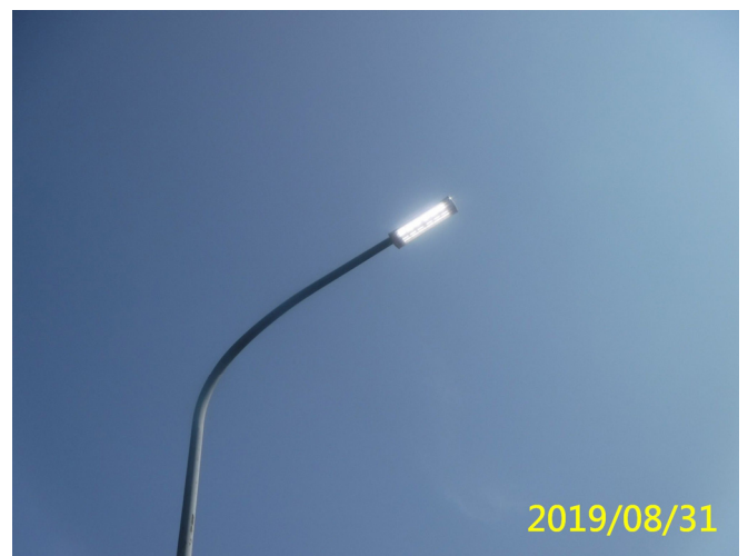
10. 108/8/31 堰區及北岸沉砂池照明路燈故障更換 LED 燈具
