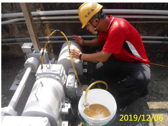
59. 108/12/06 斗六堰閘門群組年度減速機機 油更換中
