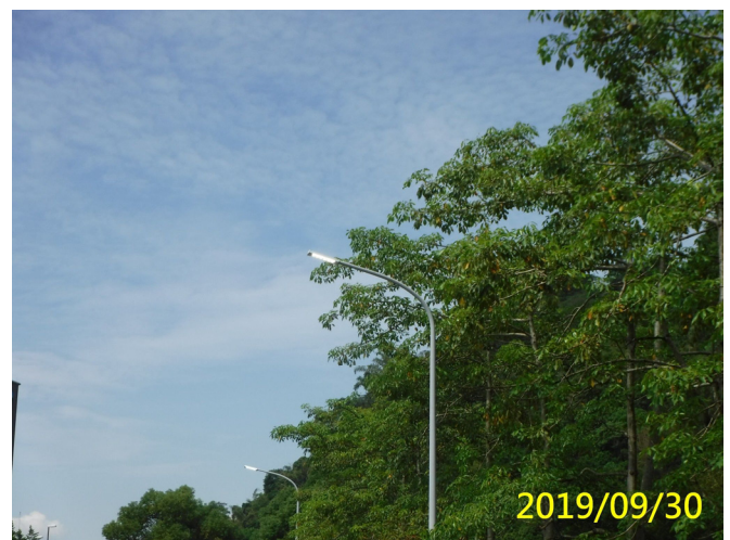
12. 108/9/30 攔河堰區北引道路燈迴路燈具漏電故障更換 LED 燈具
