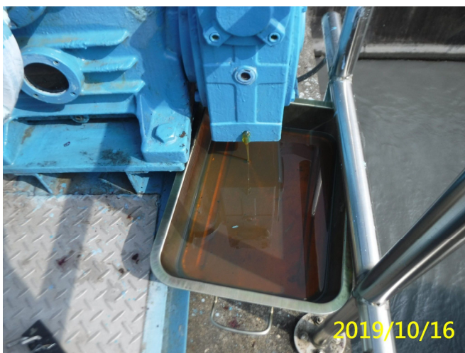
54. 108/10/16 南岸沉砂池分水門閘門更換機油
