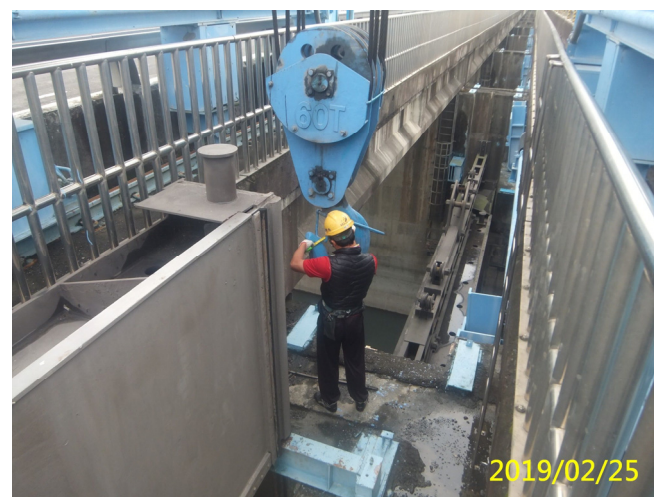
3. 108/2/25 溢洪道 60T 吊車定期工檢
