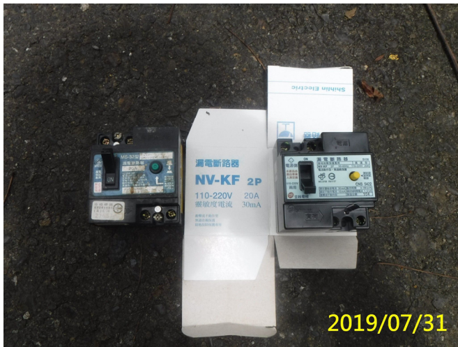
7. 108/7/31 北岸沉砂池照明箱內漏電斷路器故障更換新品
