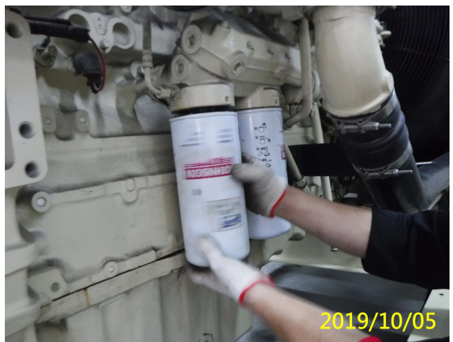
42. 108/10/5 水工機械用 350KW 發電機更換機油濾清器
