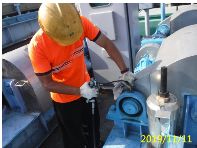
56. 108/11/11 北岸進水口吊門機各軸承黃油 加注潤滑
