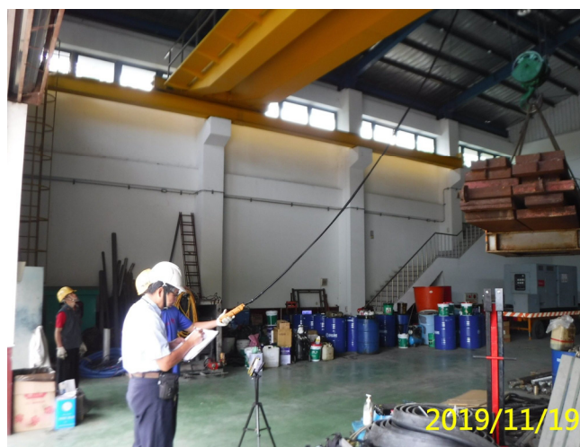
6. 108/11/19 倉庫 10t 吊車定期工檢
