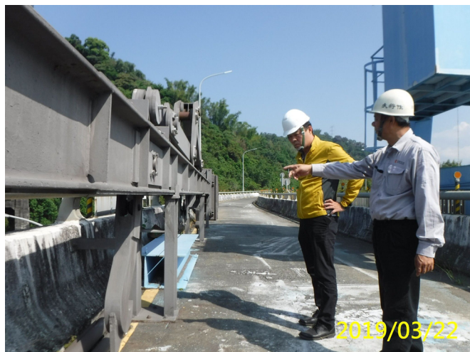
1. 108/3/22 機械技師至溢洪道閘門執行技師業務
