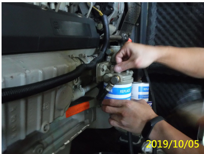
43. 108/10/5-60KW 移動式發電機更換機油濾清器
