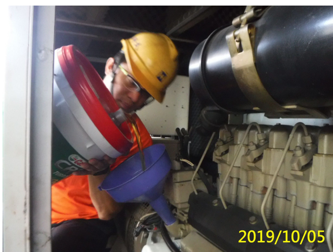
47. 108/10/5 集管中心大樓用 400kw 發電機更換機油中
