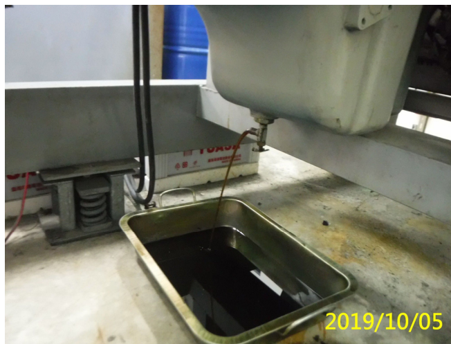
44. 108/10/5 集管中心大樓用 400kw 發電機更換機油
