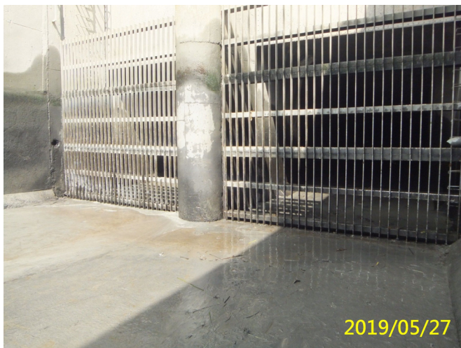
7. 108/5/27 南岸聯絡渠道攔污柵垃圾阻塞清除後
