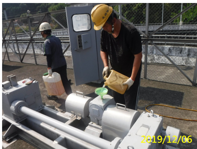
60. 108/12/06 斗六堰閘門群組年度減速機機 油更換後
