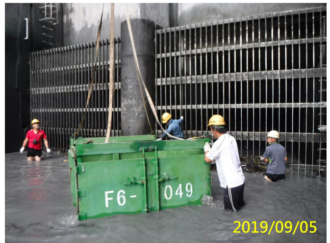
10. 108/9/5 南岸渠道攔污柵垃圾阻塞清除作業中
