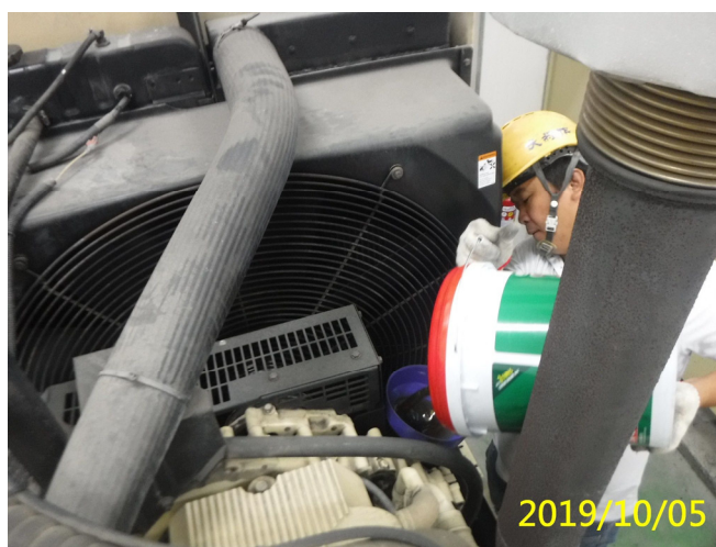
48. 108/10/5 水工機械用 350KW 發電機更換機油中
