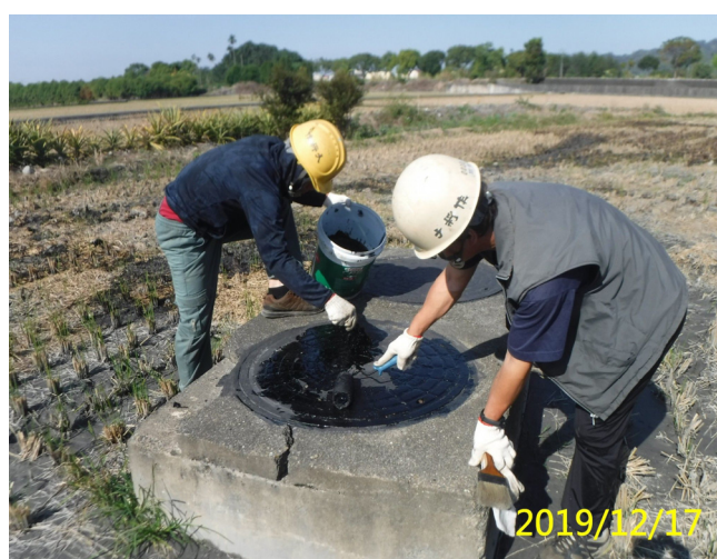
2. 108/12/17 人孔蓋生鏽進行除鏽油漆中
