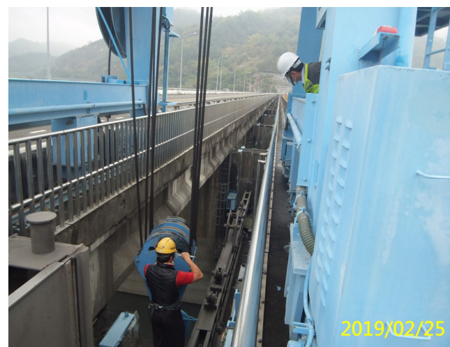
4. 108/2/25 溢洪道 60T 吊車定期工檢
