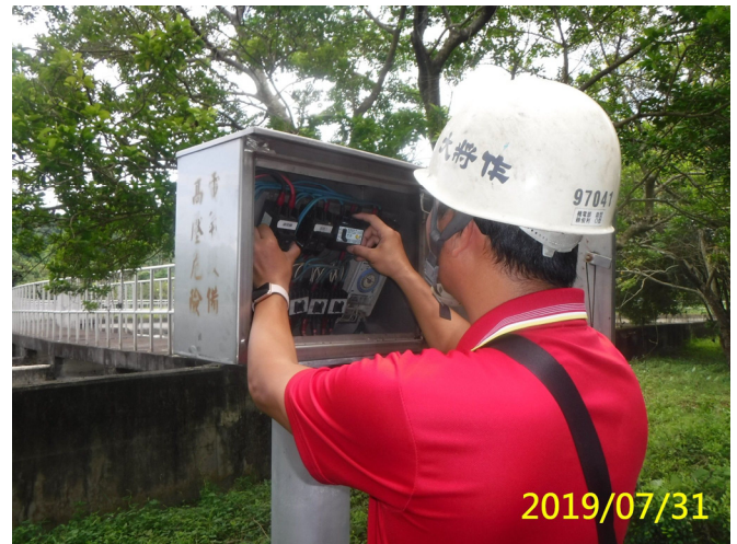
8. 108/7/31 北岸沉砂池照明箱內漏電斷路器故障更換新品
