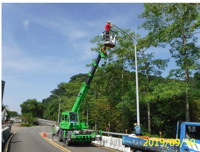
11. 108/9/30 攔河堰區北引道路燈迴路燈具漏電故障更換 LED 燈具
