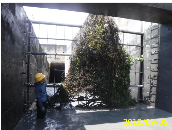
11. 108/9/5 南岸渠道攔污柵垃圾阻塞清除作業中
