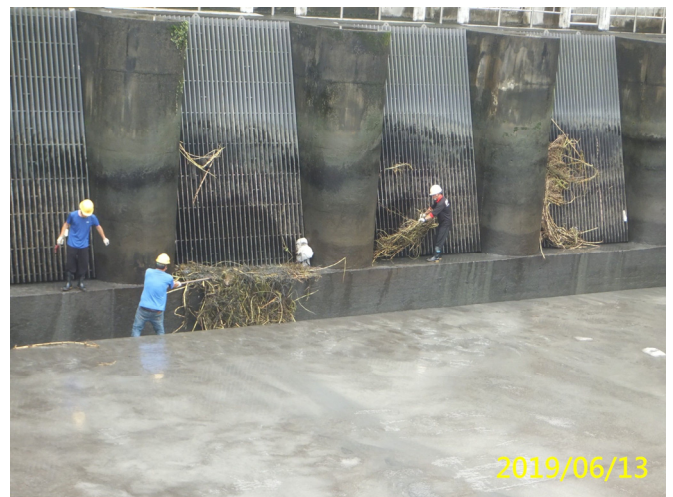
8. 108/6/13 北岸 3-3 段攔污柵垃圾阻塞清除作業中
