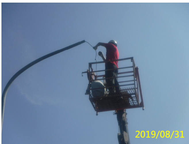
9. 108/8/31 堰區及北岸沉砂池照明路燈故障更換 LED 燈具
