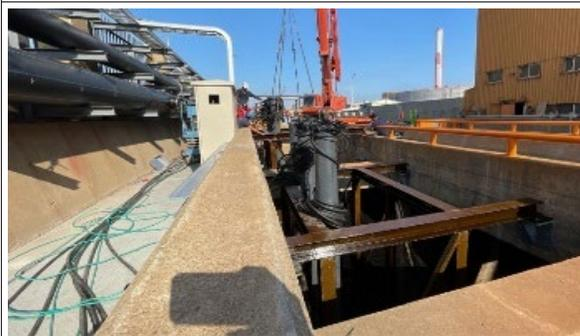
圖10-2-14海水取水泵安裝
