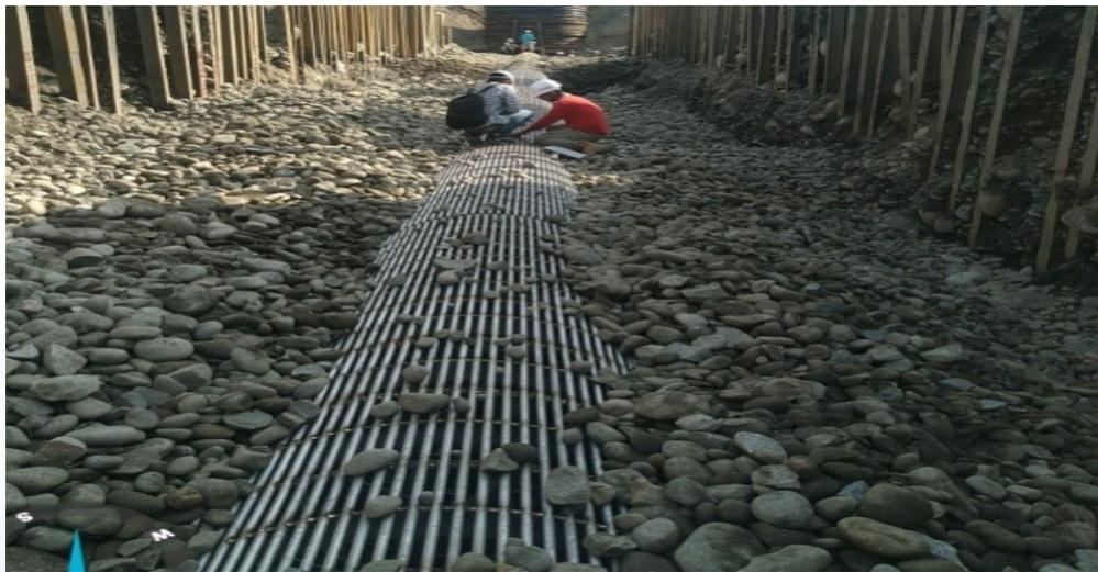
圖10-2-23 不銹鋼集水管埋設與濾層回填
