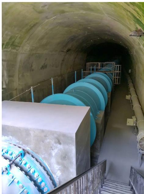
圖8-1-1 110年度鯉魚潭水庫所轄設施更新改善工程-鋼管除鏽塗漆處理
