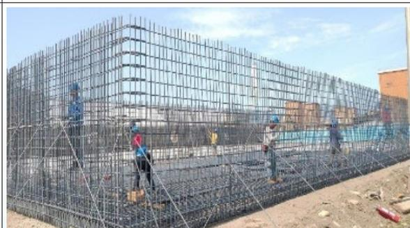
圖10-2-17 RC 海水貯槽施工
