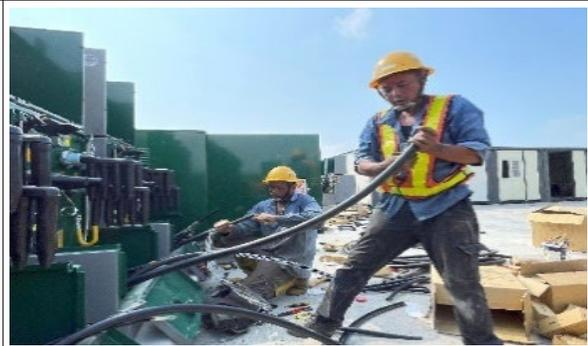
圖10-2-11 台電高壓線路引接施工
