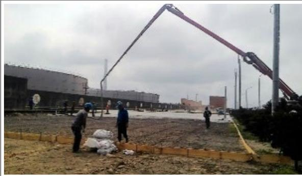
圖10-2-10 整地工程及混凝土澆置
