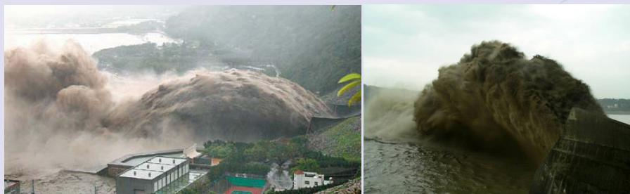
▲石門水庫艾利颱風尖峰流量 8,594 立方公尺 / 秒，為建庫以來第 2 大，溢洪道及排洪隧道均排放高濃度渾水層。
