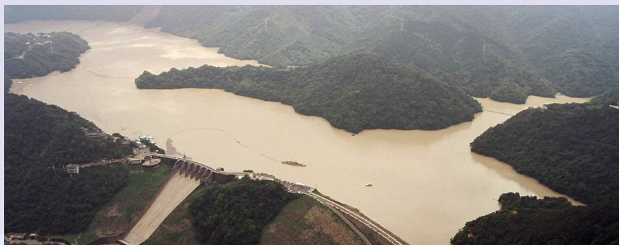
▲艾利颱風 8/23 至 8/29 累計入庫水量 8.0 億立方公尺，約為 3.4 倍的庫容，於 8/29 從高空拍攝石門水庫累積高濃度渾水潭，2004 年底水庫新增淤積量 2,788 萬立方公尺，約為歷年（40 年）淤積量 5,614 萬立方公尺的一半，且影響桃園 18 天無法正常供水。
