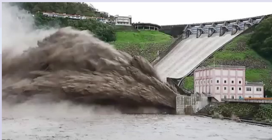
▲蘇力颱風期間電廠排砂隧道操作實況 (2013 年)
