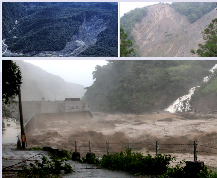
▲石門水庫於 2004 年艾利颱洪造成集水區崩塌 601 公頃，原始林地崩塌佔總崩塌面積的 82%，產生高濃度渾水逕流入庫。
