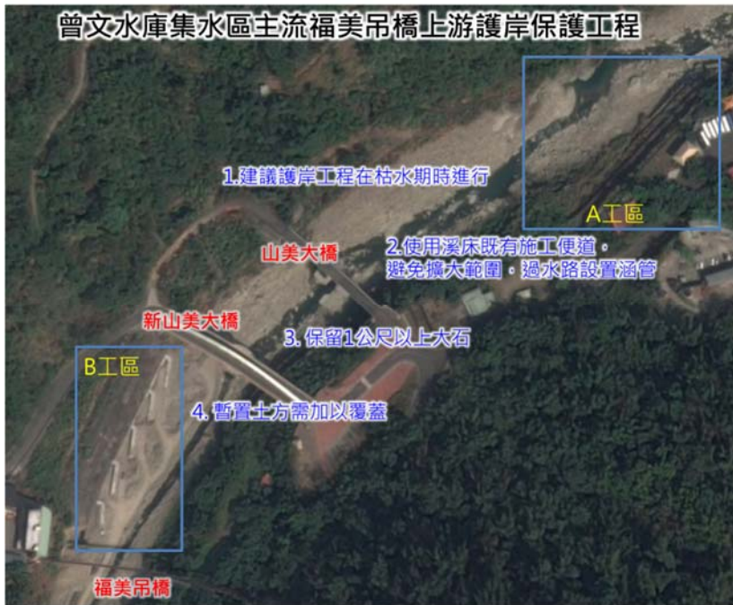
工程生態檢核施工階段照片及說明
