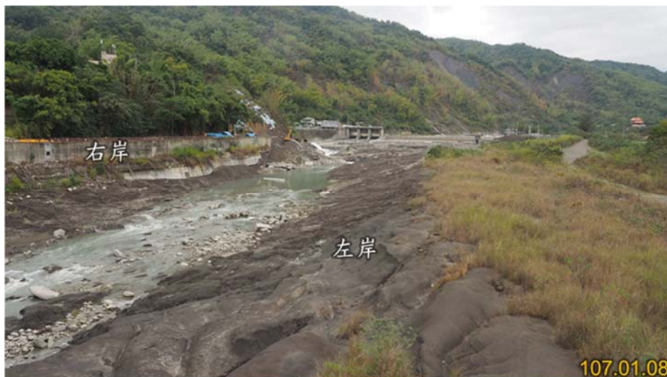
圖2 預定工區原有溪流結構
