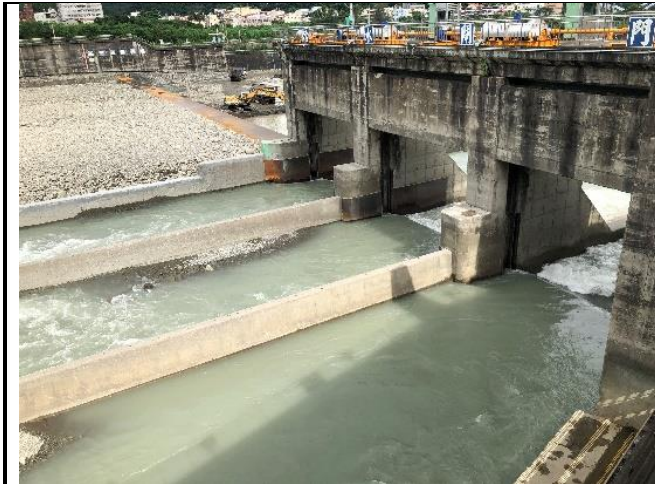
108.09.18 施工位置現況
