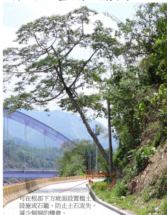
上圖：位於施工位置中段，有一株山黃麻大樹，隨土石滑坡，傾斜約 30 度。
