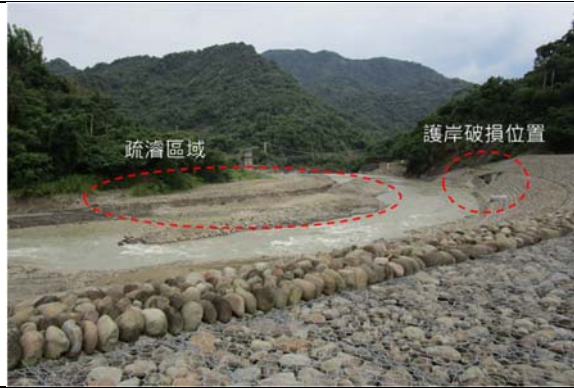
圖 1. 河道施工前環境現況。
