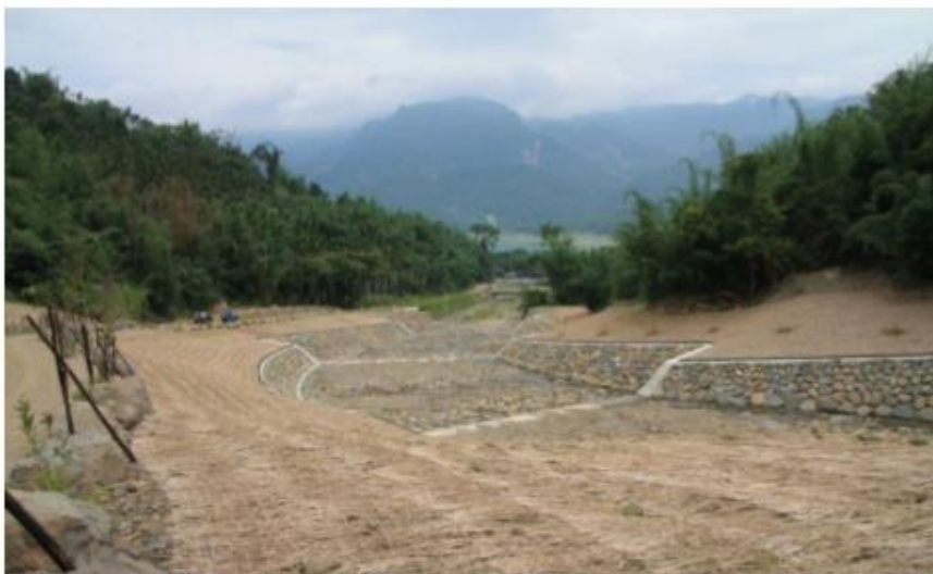
複式斷面設計的緩坡護岸
