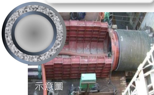
WSP兩層鋼管 內襯混凝土
