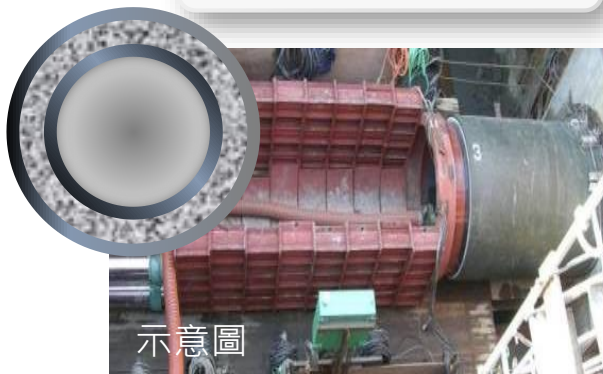
WSP兩層鋼管 內襯混凝土
