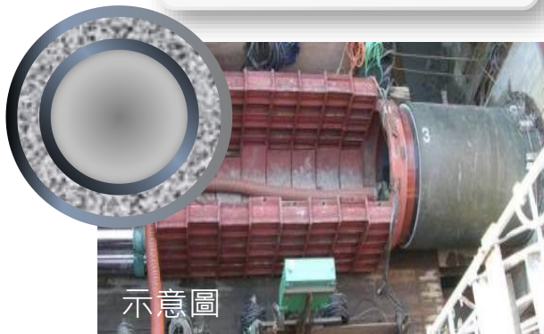
WSP兩層鋼管 內襯混凝土
