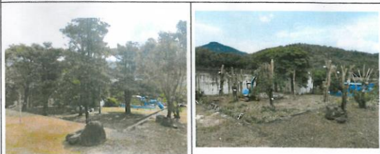
日期:109.05.26 說明:施工前
