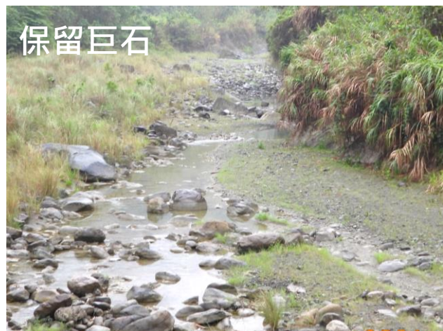
柔性工法及堆石緩坡
