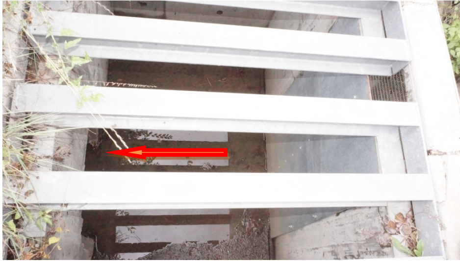
照片 5-6 豎井式出流工與聯外排水路箱涵連結情形
