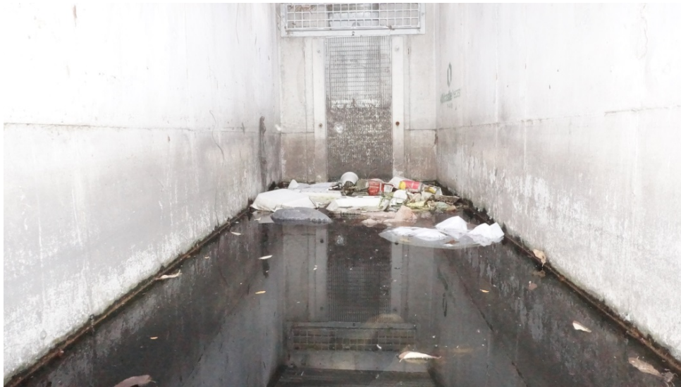
照片 5-4(B) 出流工之微前池之雜物與出流工攔污柵設施
