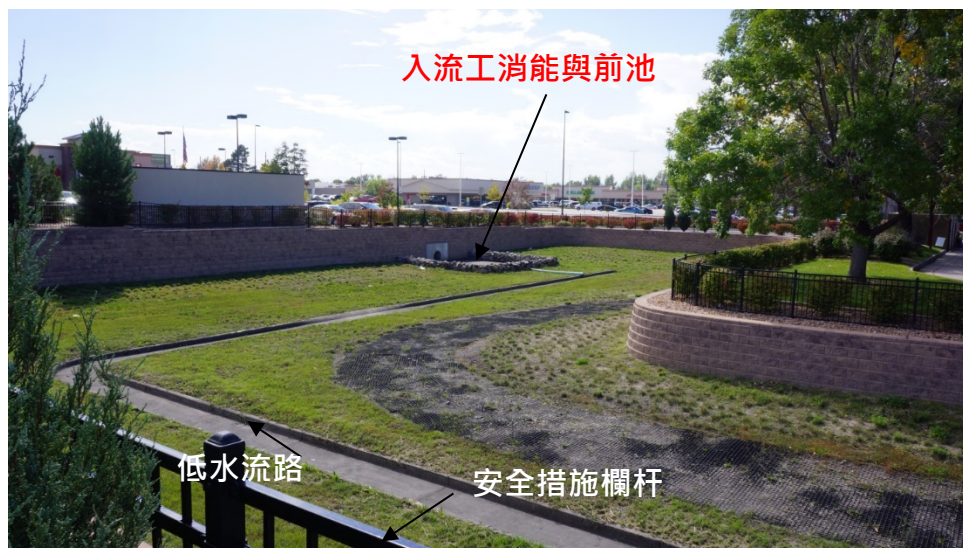
照片 5-1 滯蓄洪設施入流工前池周遭安全設施與低水流路
