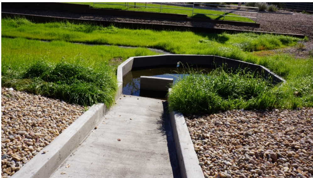
照片 5-3 入流工之消能與沉沙前池
