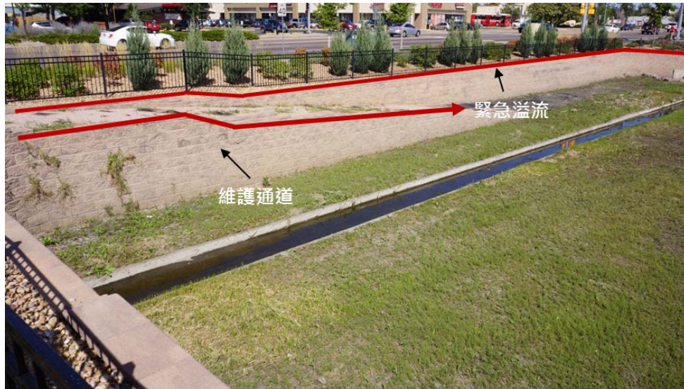
照片 5-2 滯蓄洪設施為維護通道及降低堤岸高程為緊急溢流
