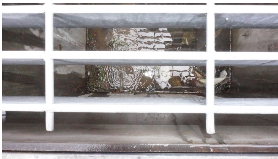
照片 5-5 微前池排放蓄水至豎井式出流工之情形
