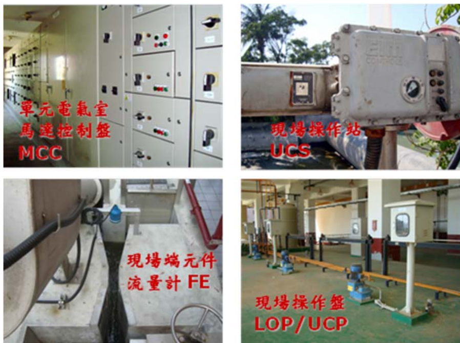
圖 5.10 儀控系統組合配置實景圖之二
