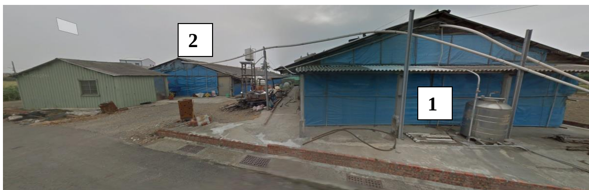
圖 5.15 曾文溪排水新設疏洪箱涵用地範圍內使用情況照片(編號 1、2)
