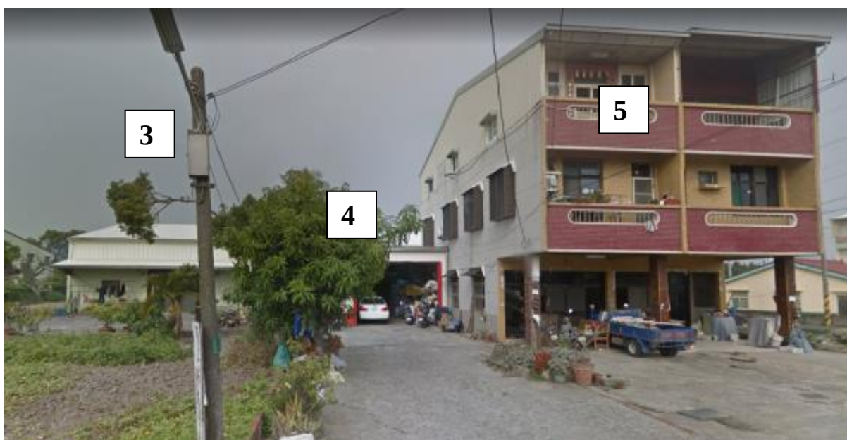
圖 5.16 曾文溪排水新設疏洪箱涵用地範圍內使用情況照片(編號 3、4、5)
