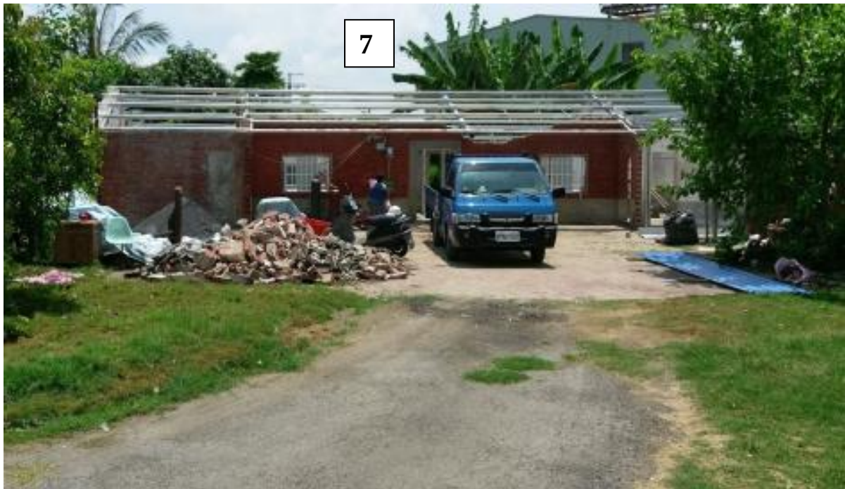
圖 5.18 曾文溪排水新設疏洪箱涵用地範圍內使用情況照片(編號 7)
