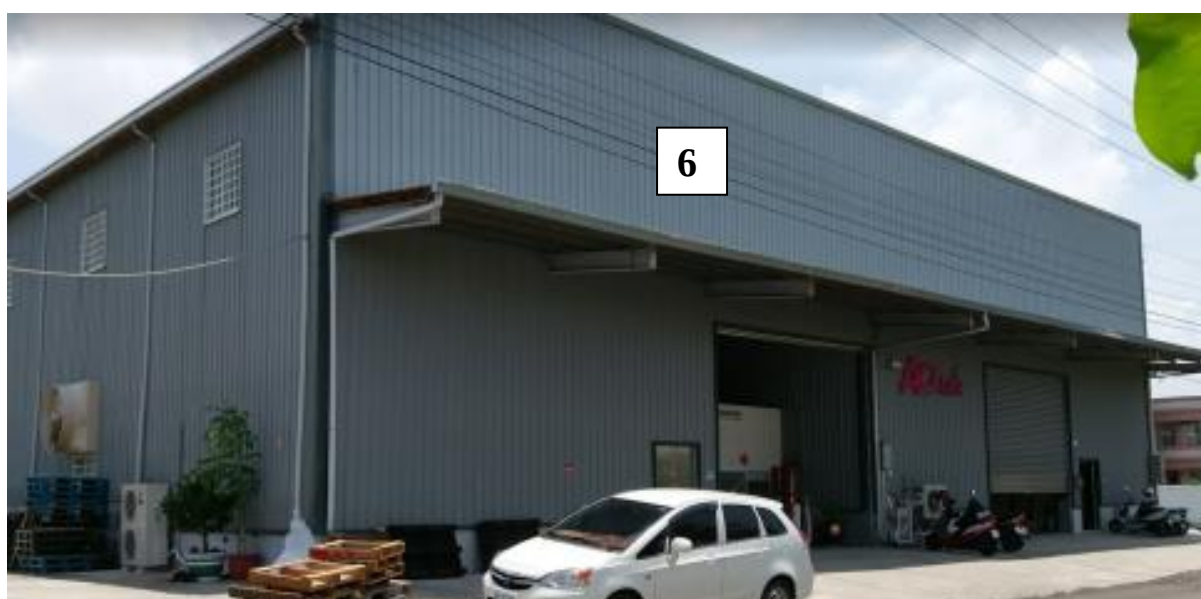
圖 5.17 曾文溪排水新設疏洪箱涵用地範圍內使用情況照片(編號 6)
