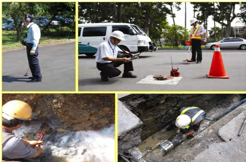
圖 9 北水處漏水檢測與修漏作業
