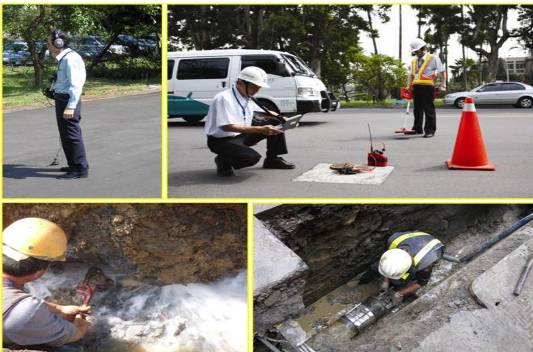
圖 9 北水處漏水檢測與修漏作業
