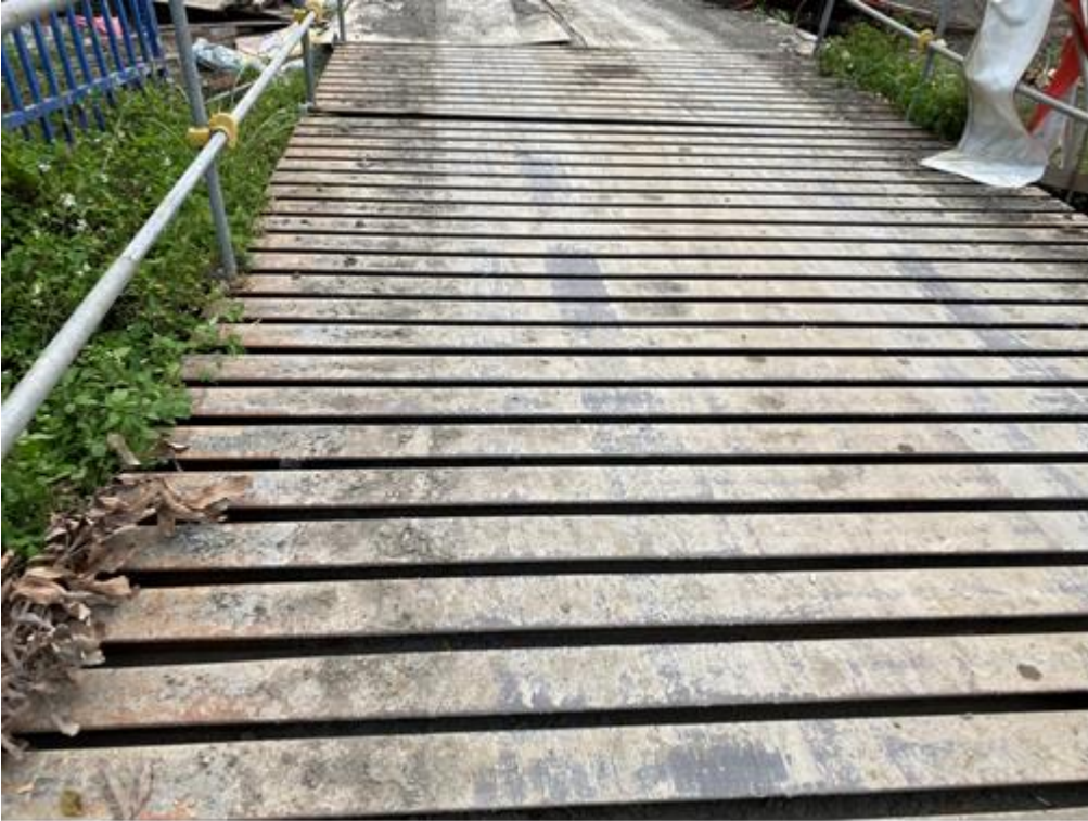
洗車台完成面
