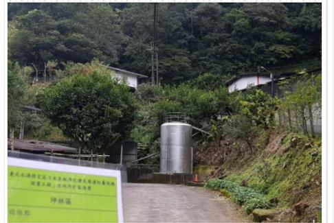
建築物位於擋土牆上方，於擋土牆下方(基地內)設置淨化槽
