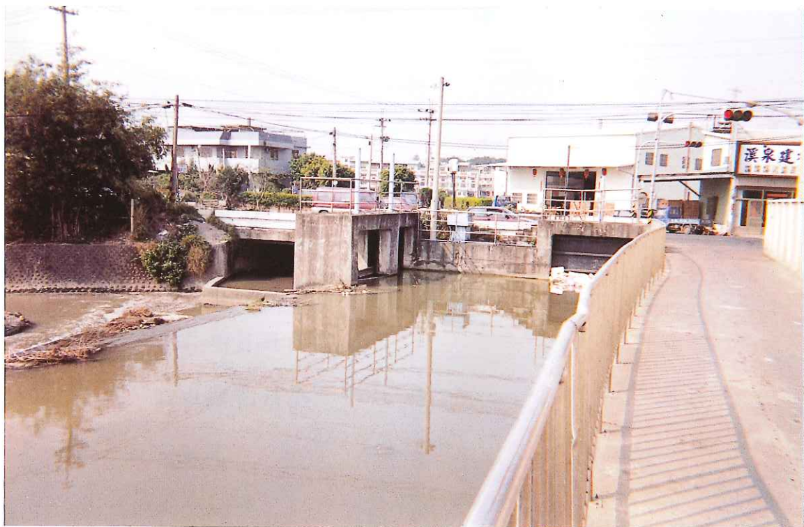
同安厝坑排水“學田 4 號橋”處之灌溉補助水源引水口
