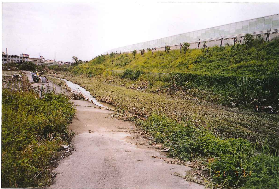
桃芝颱風造成高速公路同安厝坑排水淹水情形
