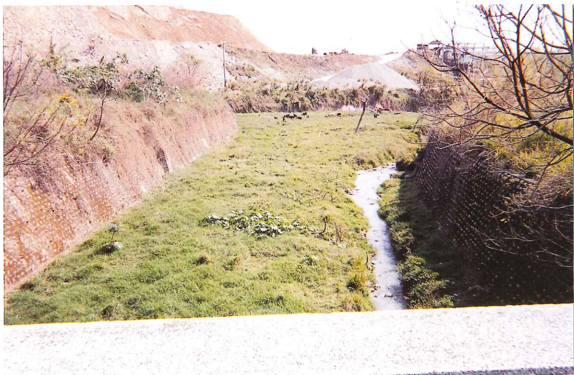
同安厝坑排水上游多已改善完畢
