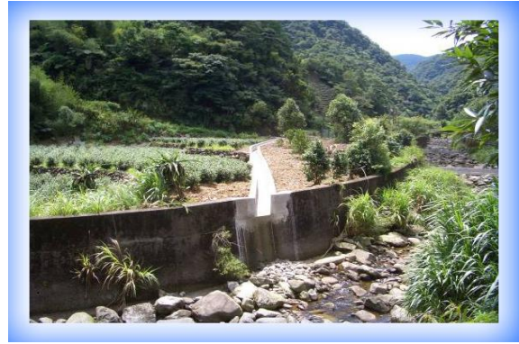
相片 4-14 坪林區虎寮潭-U 型溝
