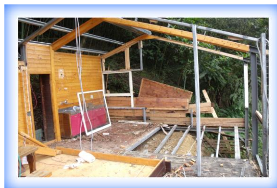
相片 2-2 違建拆除後現場照片
