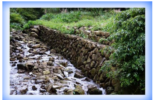
相片 4-8 坪林區藤寮坑-鋪排塊石護岸
