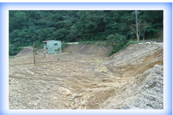
相片 3-6 開挖整地
