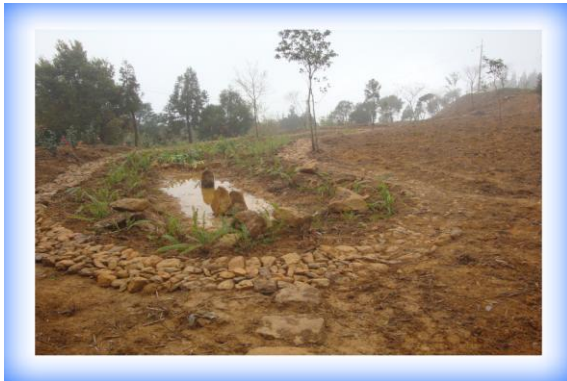
相片 3-1 開挖整地
