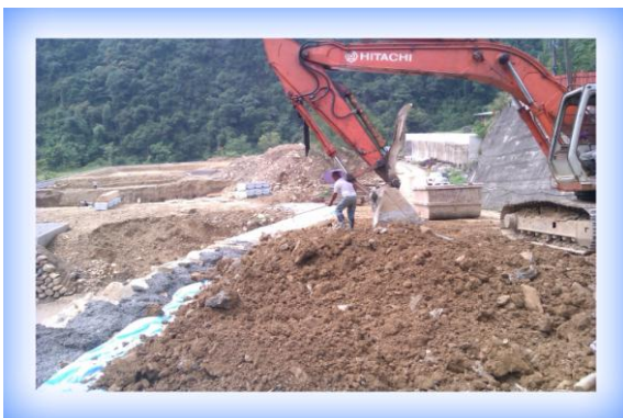
相片 3-3 開挖整地
