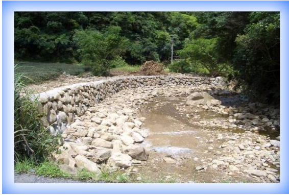
相片 4-13 坪林區虎寮潭-鋪排塊石護岸
