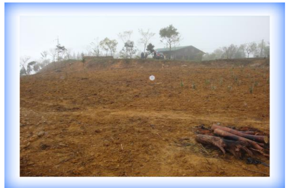
相片 3-4 開挖整地
