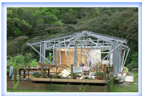
相片 2-1 違建拆除前現場照片
