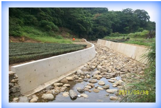
相片 4-15 石碇區柑腳溪-RC 護岸
