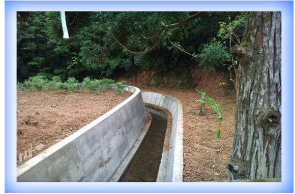
相片 4-6 雙溪區料角坑-RC 護岸
