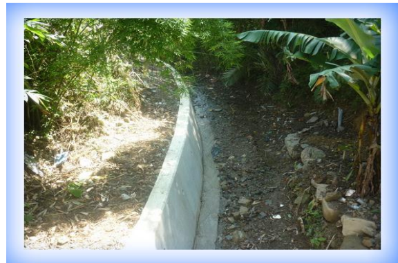
相片 4-16 坪林區水德-RC 護岸
