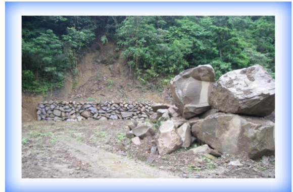
相片 3-2 開挖整地
