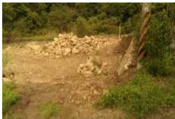
相片 3-2 開挖整地
