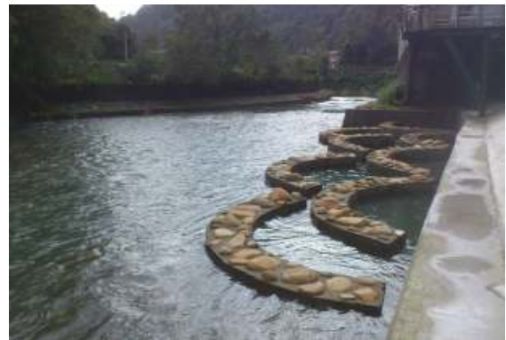
相片 4-16 金瓜寮-護坦工
