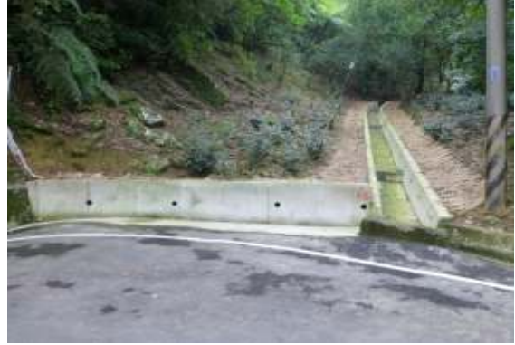
相片 4-6 土巷產業道路-U 型溝、L 型溝
