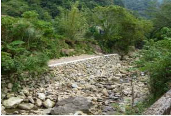
相片 4-21 北 105 縣道 7K 處-砌石護岸
