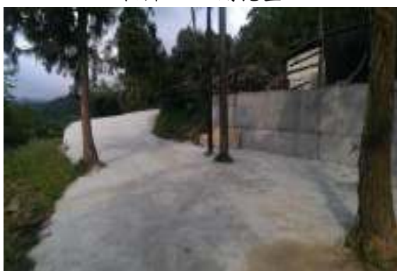
相片 3-3 開挖整地
