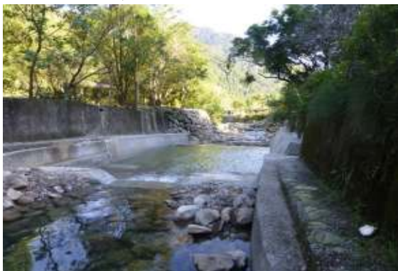
相片 4-29 平廣路 290 號-基礎填縫
