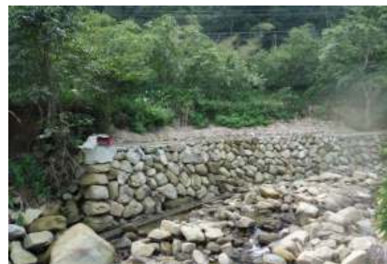
相片 4-19 平廣路 1 段 330 號旁-基礎填縫 相片 4-20 明潭橋旁-砌塊石護岸
