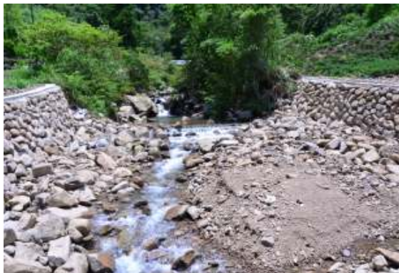
相片 4-15 東坑-漿砌塊石護岸
