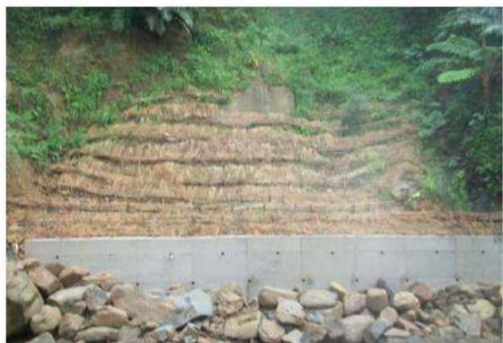
相片 4-23 新潭路 2 段 165 號-RC 護岸
