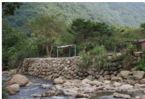
相片 4-17 平廣路 1 段 201 巷旁-RC 護岸 相片 4-18 平廣路 1 段 290 號旁-砌塊石護岸
