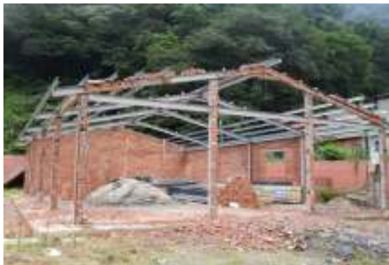
相片 2-1 違建拆除後現場照片
