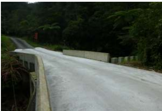
相片 4-11 料角坑-箱涵、RC 護岸
