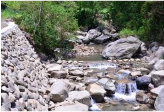
相片 4-13 下石槽-漿砌塊石護岸
