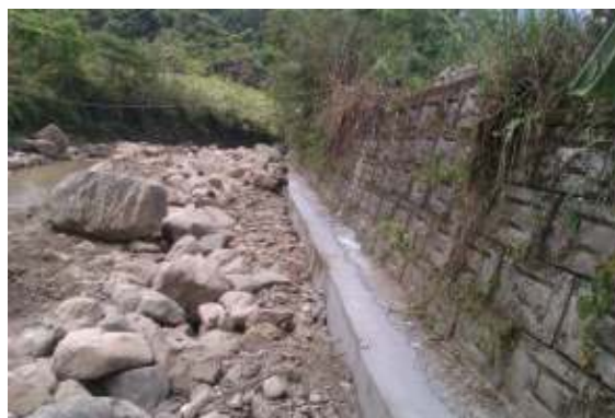
相片 4-19 平廣路 1 段 330 號旁-基礎填縫 相片 4-20 明潭橋旁-砌塊石護岸
