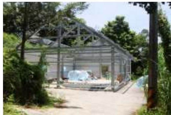
相片 2-2 違建拆除後現場照片
