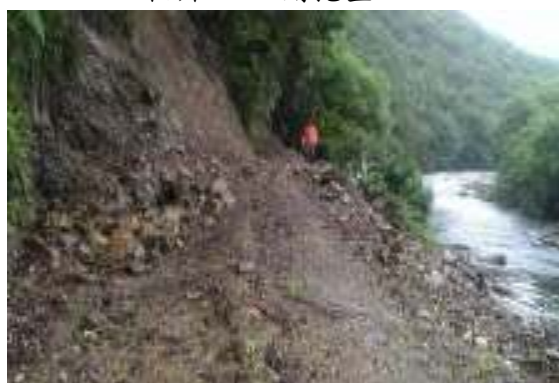
相片 3-4 開挖整地
