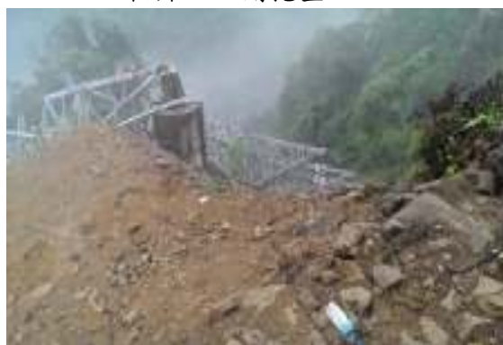
相片 3-6 開挖整地
