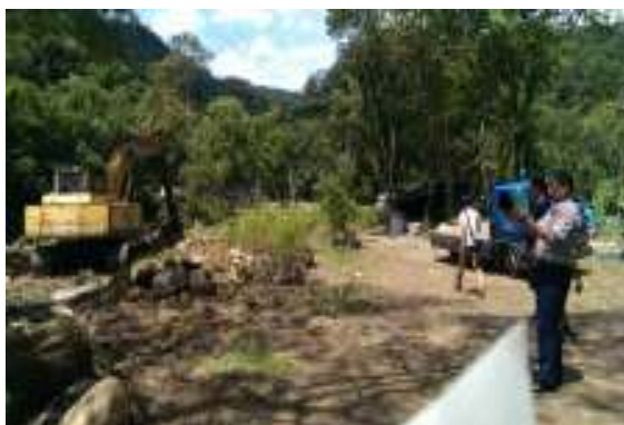
相片 3-1 開挖整地
