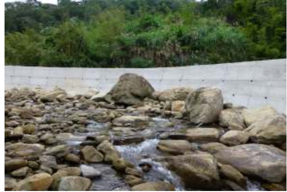
相片 4-22 新潭路 2 段 120 號-RC 護岸
