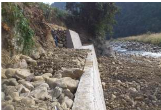
相片 4-31 虎寮潭-RC 護岸
