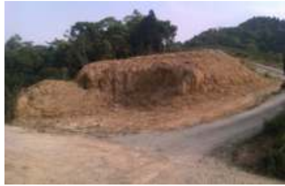
相片 3-2 開挖整地
