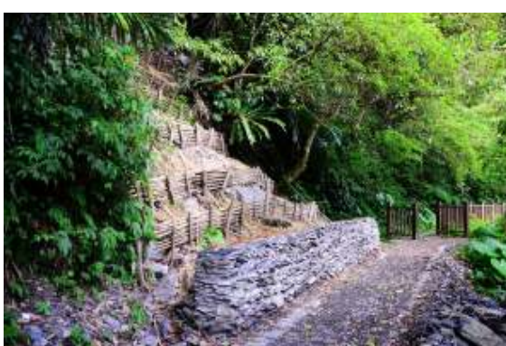
相片 4-18 混凝土亂砌石擋土牆、打樁編柵植生
