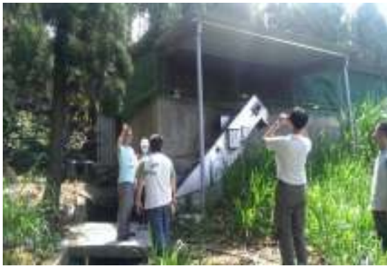
相片 3-7 養鹿場固液分離設施
