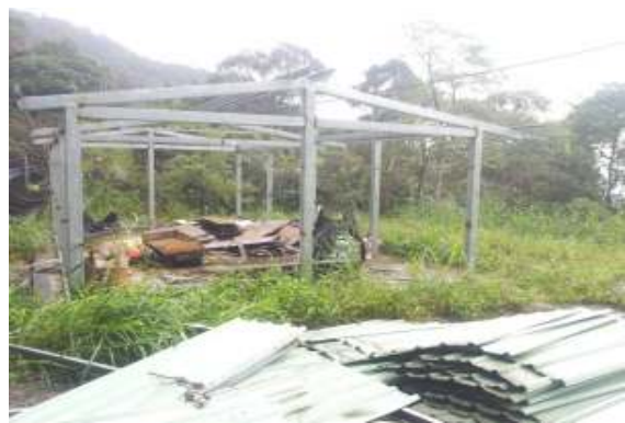
相片 2-2 違建拆除後現場照片
