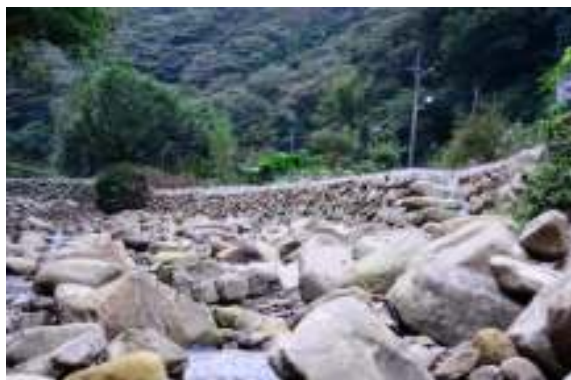
相片 4-11 上德里虎寮潭-亂砌石護岸
