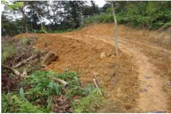
相片 3-1 開挖整地
