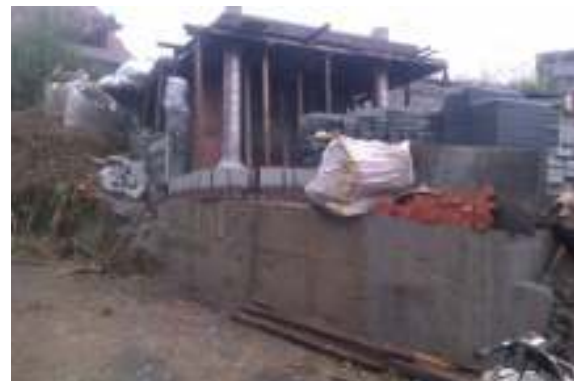
相片 3-6 開挖整地
