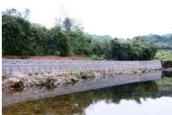
相片 4-19 料角坑北勢溪造型護岸
