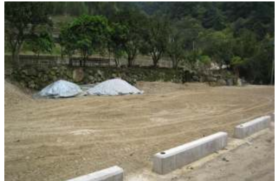
相片 3-4 開挖整地
