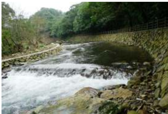
相片 4-20 亂砌石護岸、拱形固床工
