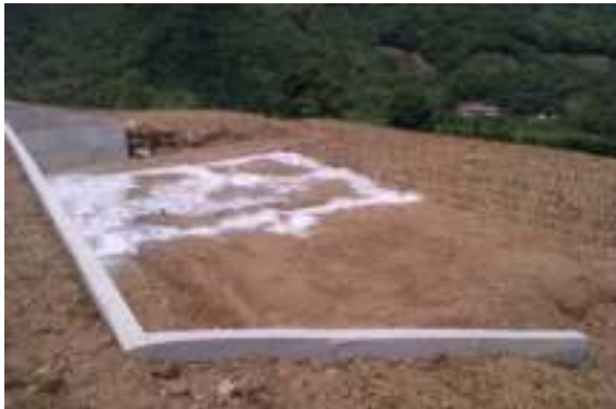
相片 3-3 開挖整地
