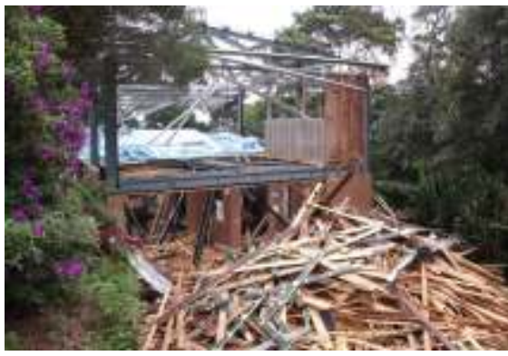
相片 2-1 違建拆除後現場照片
