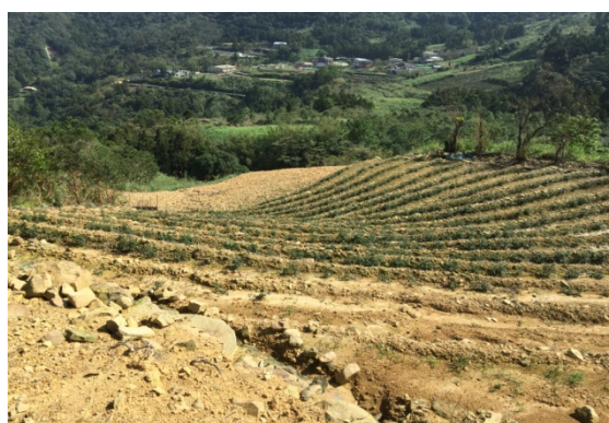
相片 3-4 開挖整地
