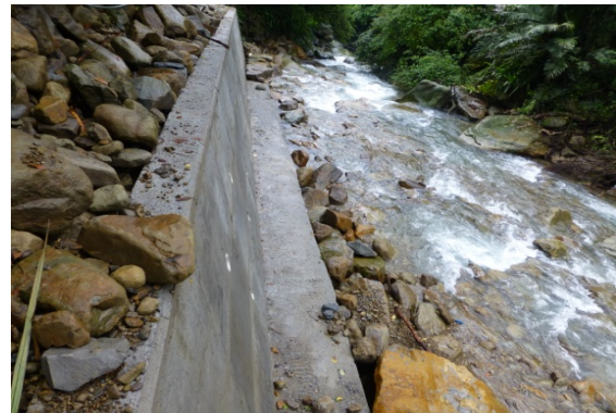
相片 4-20 新潭路 2 段 189 號-RC 護岸
