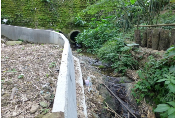
相片 4-13 料角坑 32 號-RC 護岸
