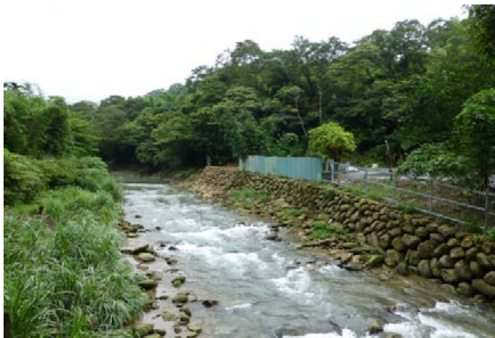
相片 4-27 磺窟橋-漿砌塊石護岸
