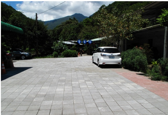
相片 4-23 大羅蘭 B-既有透水磚鋪面修復
