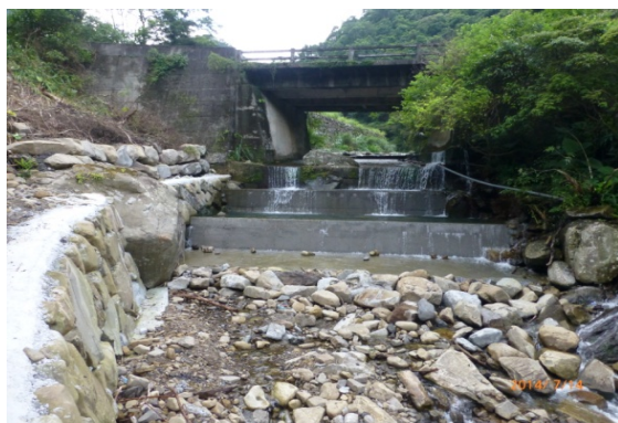
相片 4-11 下石槽-砌石護岸
