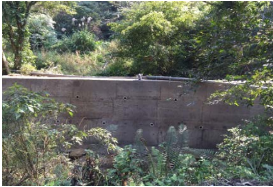
相片 4-25 新潭路 3 段 80 巷-RC 護岸
