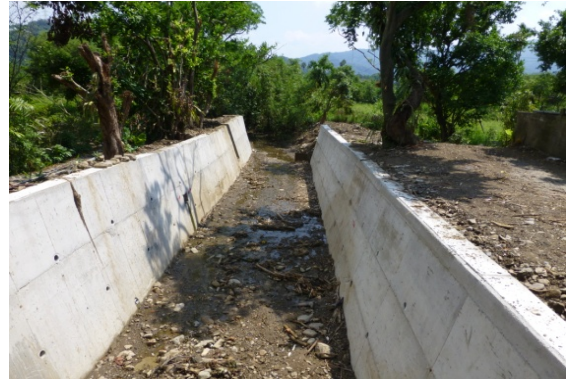
相片 4-18 新潭路 1 段 19 號-RC 護岸
