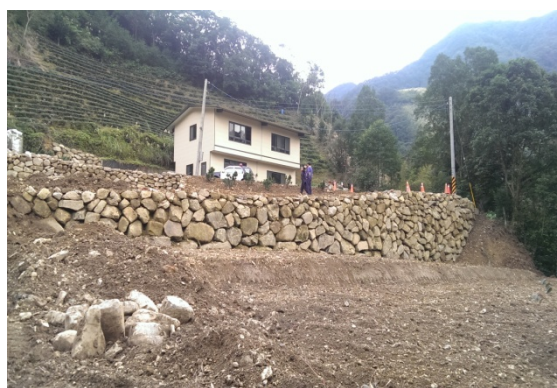
相片 3-2 開挖整地
