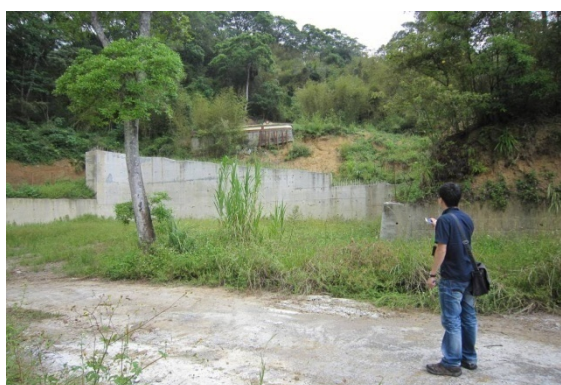
相片 3-5 開挖整地設置擋土牆
