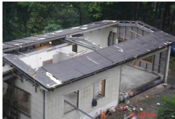
相片 2-2 違建拆除後現場照片
