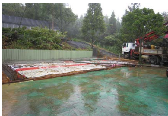
相片 3-6 開挖整地設置基礎工程
