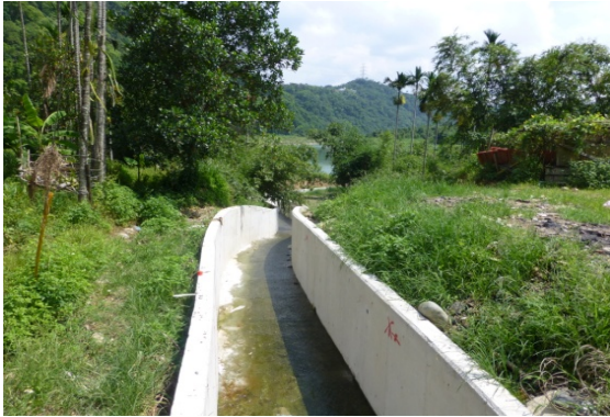
相片 4-17 新潭路 1 段 6 巷- U 型排水溝
