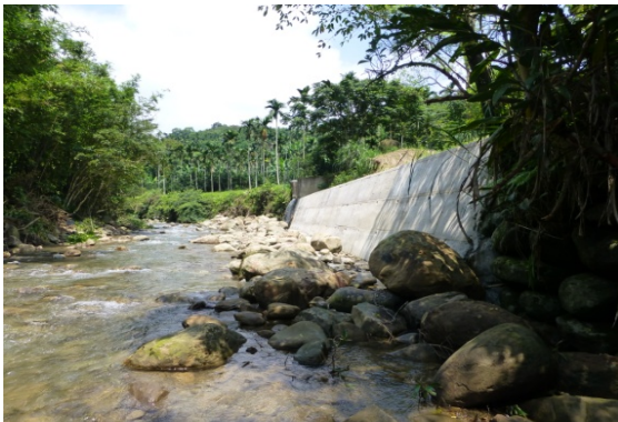
相片 4-19 新潭路 2 段 25 號- RC 護岸
