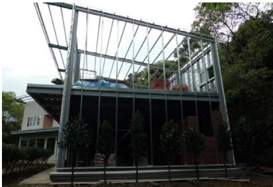
相片 2-1 違建拆除後現場照片
