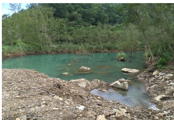
相片 3-1 開挖整地設置水池
