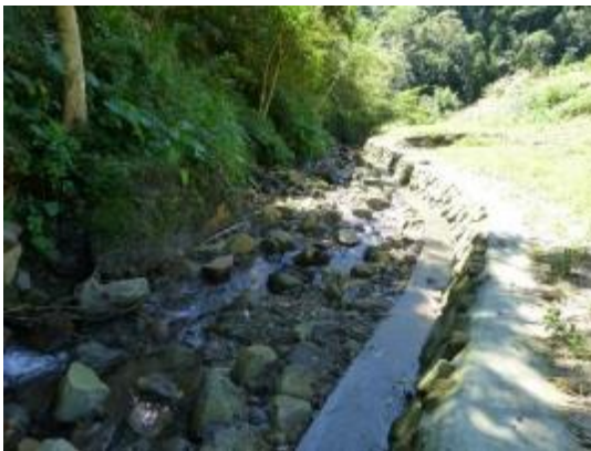
相片 4-1 上坑子口工區-亂砌石護岸
