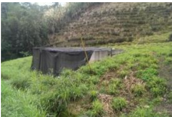
相片 3-9 養鹿場沈澱池
