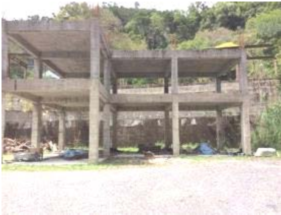
相片 2-1 違建拆除後現場照片
