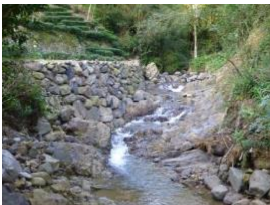
相片 4-3 柑腳坑工區-鋪排塊石
