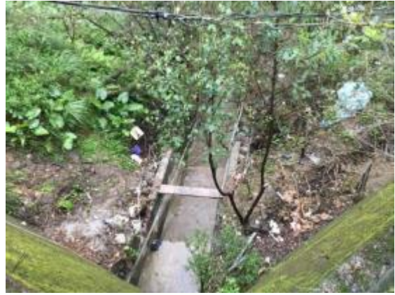
相片 4-6 環山路工區-既有排水溝修補
