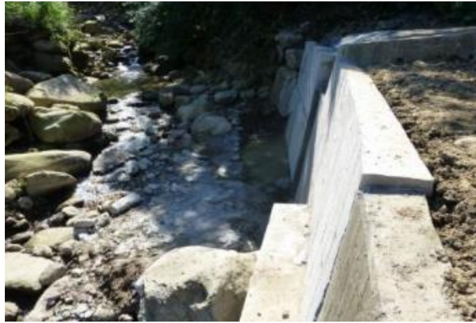
相片 4-14 塗潭工區－混凝土護岸
