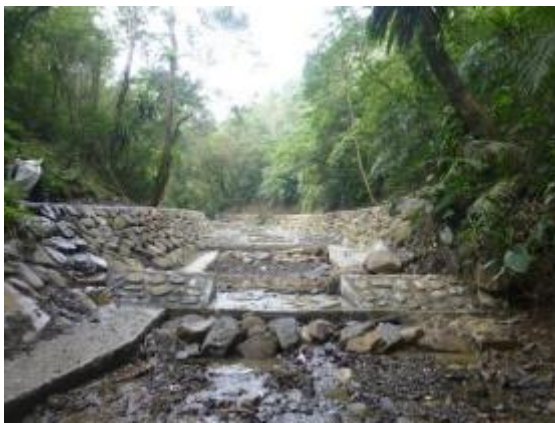
相片 4-7 坪林工區-自然鋪排塊石護岸
