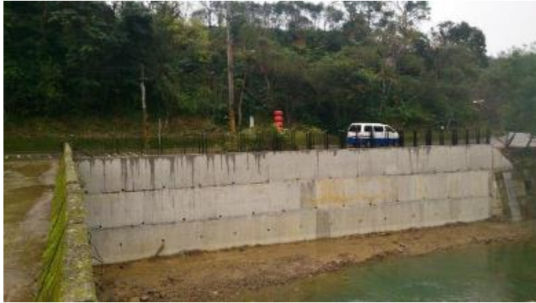
相片 4-9 鐵馬新樂園工區-半重力式擋土牆護岸
