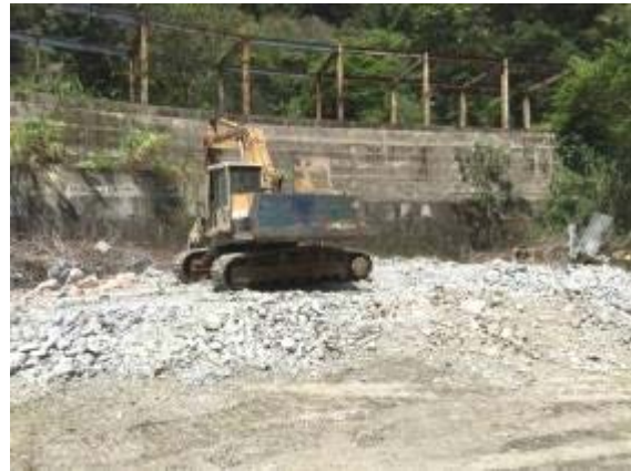
相片 2-2 違建拆除後現場照片
