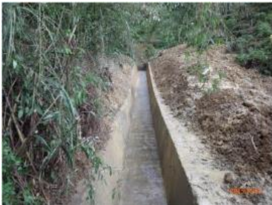
相片 4-12 上昇路工區-溝渠清淤
