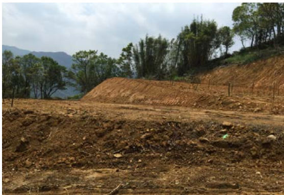
相片 3-3 開挖整地
