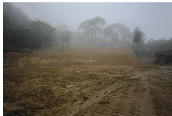
相片 3-6 開挖整地
