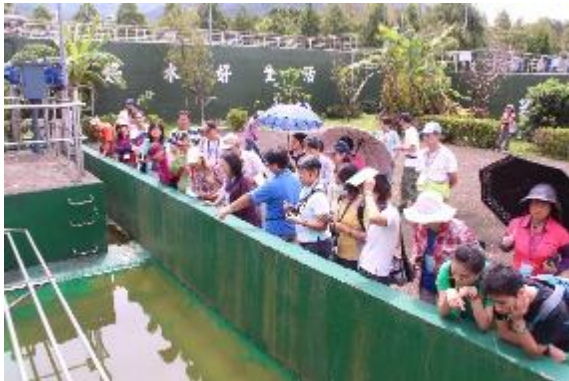
相片 6-27 坪林污水處理廠參訪
