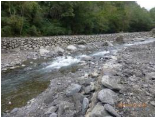
相片 4-10 大羅蘭溪工區-河道整理岸
