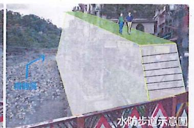
方案1：施作直立式堤防+停車場段築土堤(烏來吊橋-斷面80)
