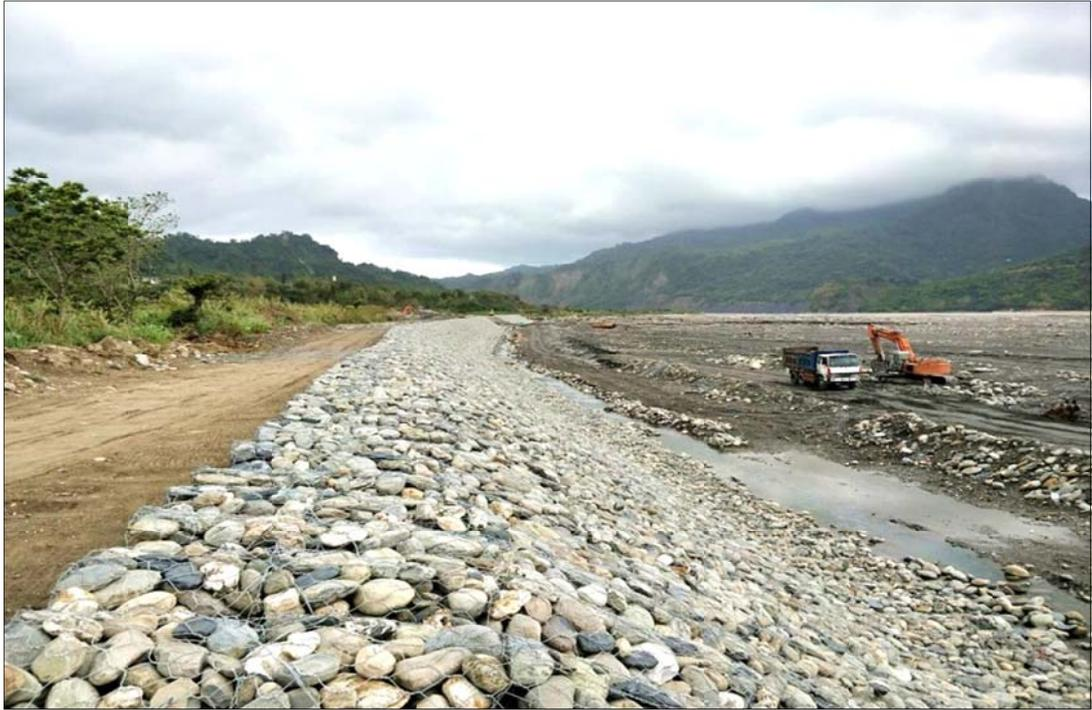
「卑南溪山里河段防災減災工程」蛇籠工施工情形(一)
