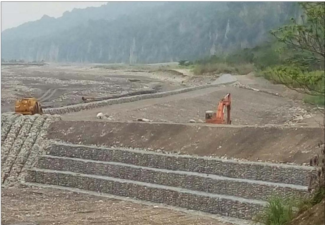
「卑南溪山里河段防災減災工程」石籠工施工情形(二)
