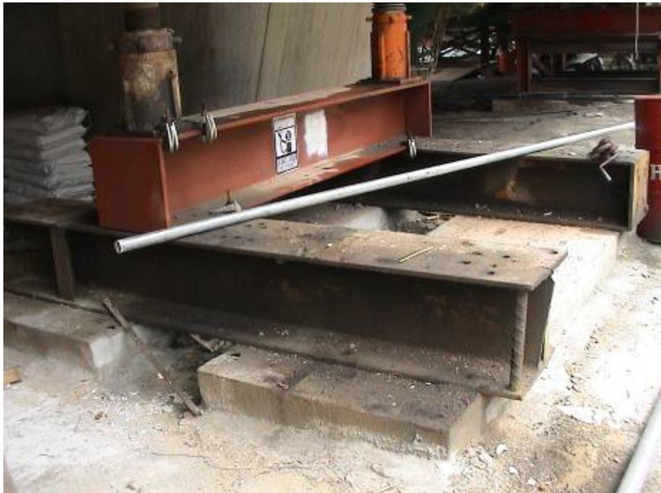
圖 132 土壤夯實、鋪設足夠強度之鋼製 H 型鋼(併排後固定)
