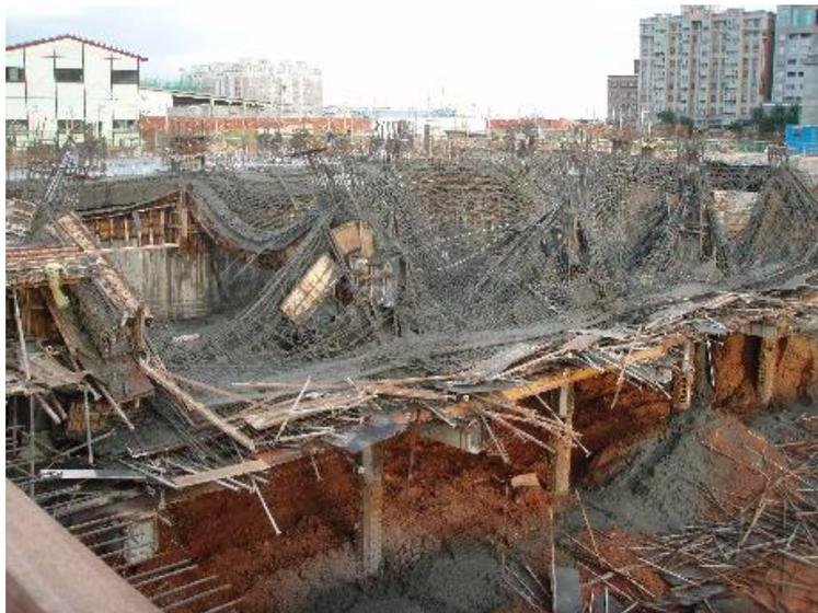
圖 28 林口某建築工地模板支撐崩塌
