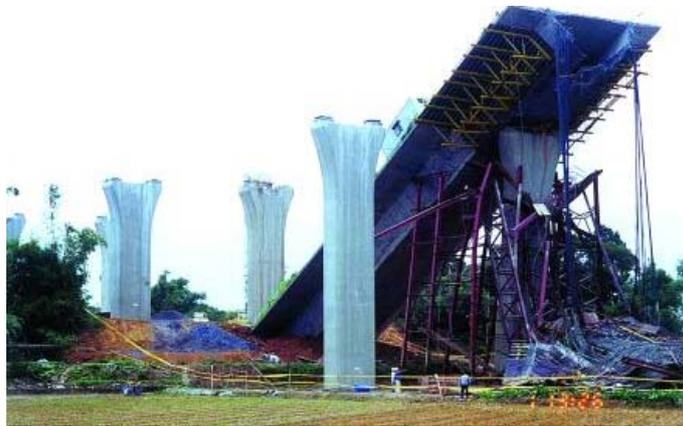
圖 34 (P28L-P29L)傾倒情形
