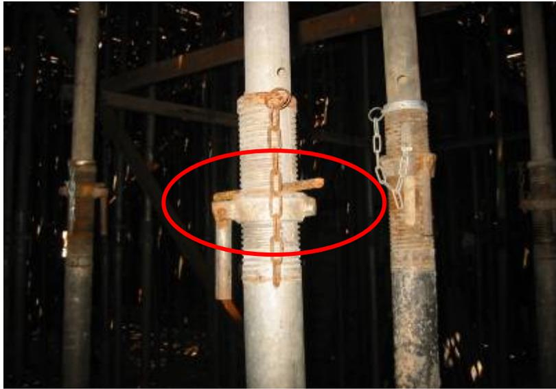
圖 80 可調式鋼管支撐接頭連接以三號鋼筋替代
