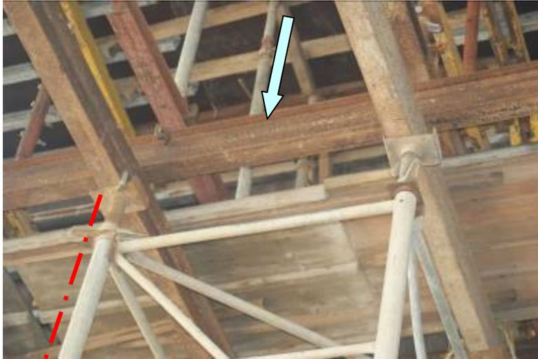
圖 100 多層方式架設偏心大使力量無法順利傳遞
