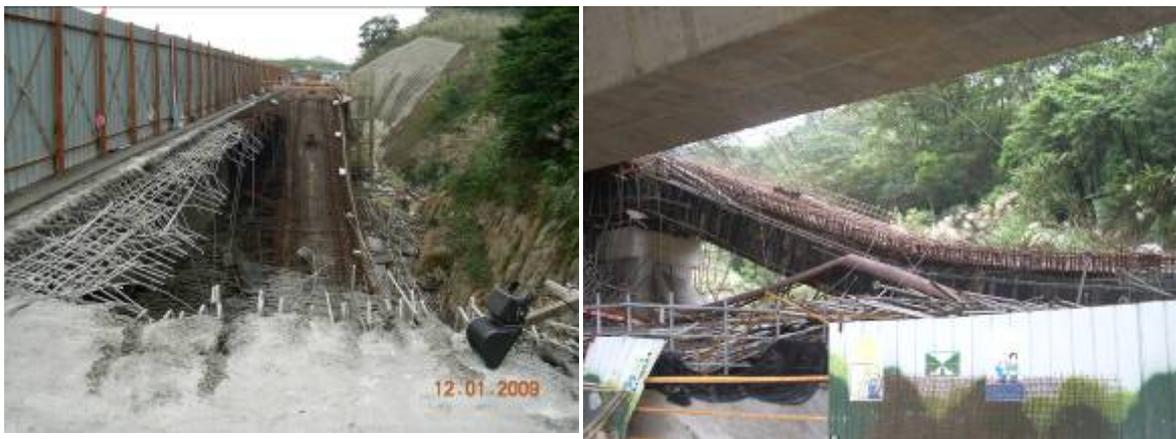
圖 22 澆置混凝土作業時模板支撐倒塌
