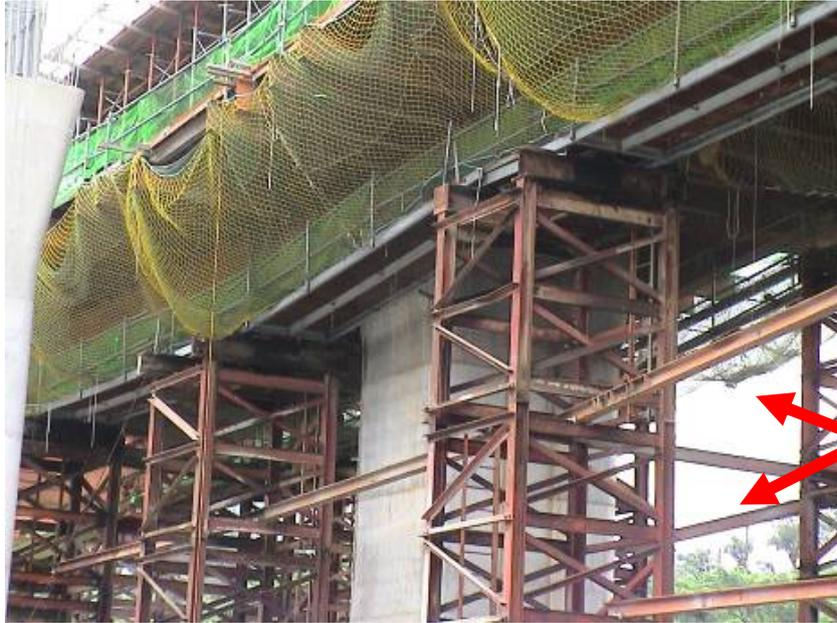
圖 161 高度超過四公尺時，於每隔四公尺以內向二方向設置足夠強度之水平繫條
