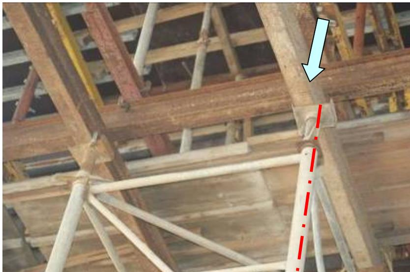
圖 101 接頭裝設偏心使力量傳遞與支柱中心不在同一線上
