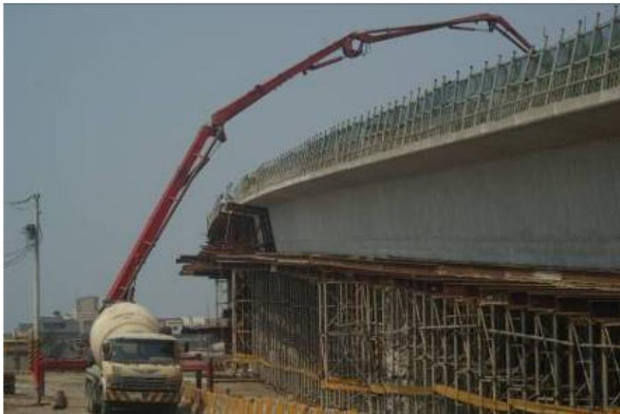
圖 55 混凝土澆置時產生施工載重
