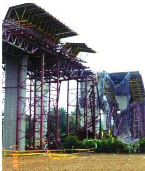
圖 35 支撐倒塌之全景
