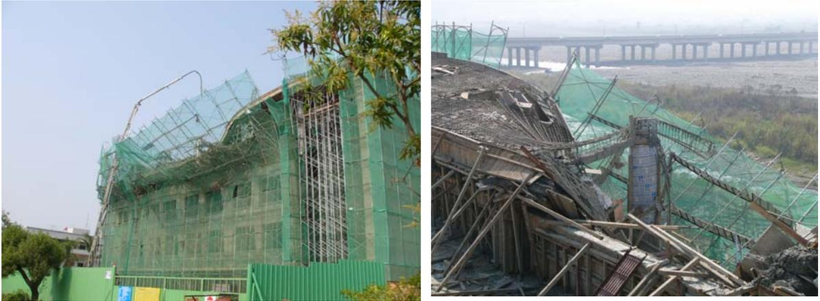
圖 29 設計時未考慮側向力導致倒塌
