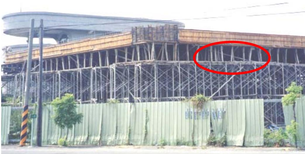
圖 91 框式施工架上方架設木支撐，木支撐穩固性不佳
