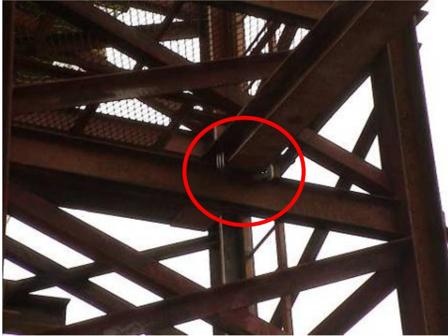
圖 157 接合處確實以鱷魚夾夾緊
