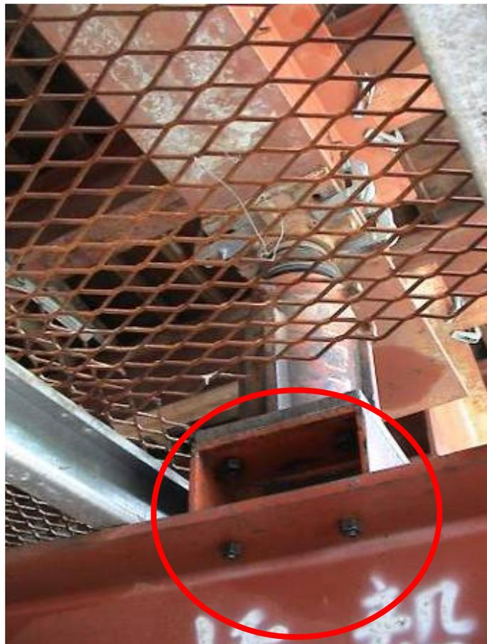
圖 158 接合處以螺栓鎖緊
