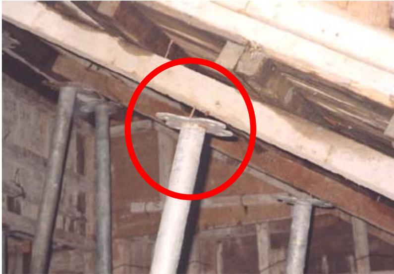
圖 82 支撐架於傾斜面僅以鐵釘固定情形
