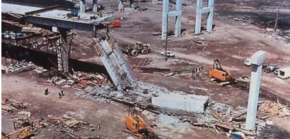
圖 44 匝道橋於澆置混凝土時崩塌
