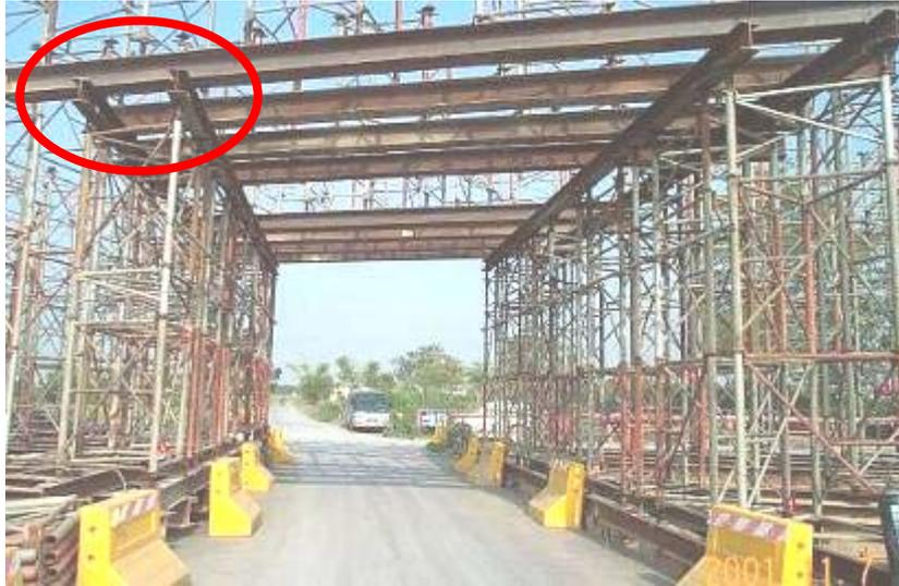
圖 150 以梁支持時，梁的兩端固定於支撐物，以防止滑動及脫落
