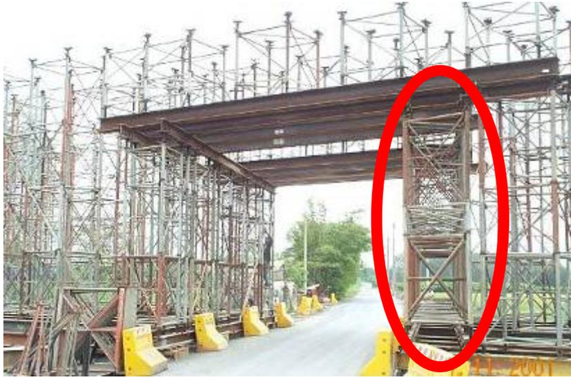
圖 149 以組合鋼柱作為支柱的支撐
