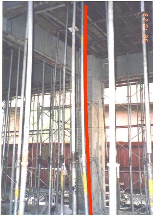
圖 67 鋼管支撐構材變形，已不堪使用
