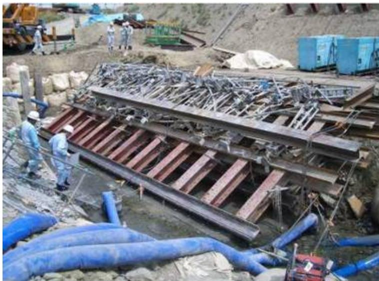
圖 39 型鋼支撐架未依圖施作
