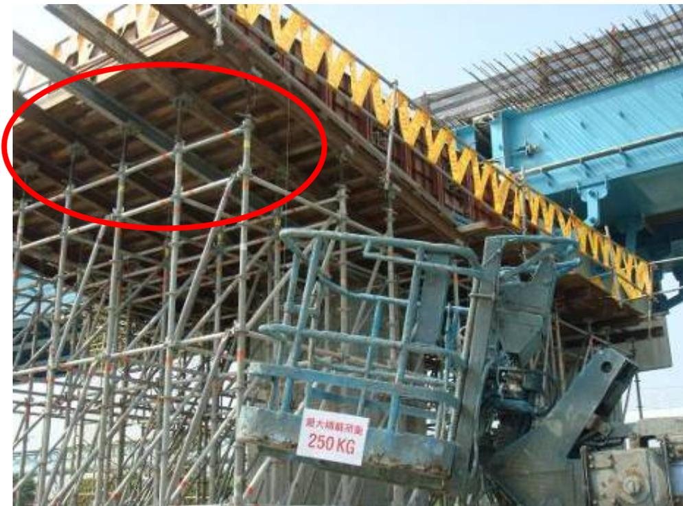
圖 163 採用同系列的高低調整器
