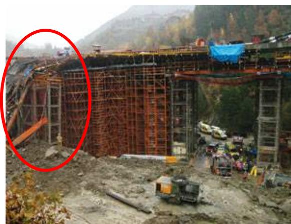
圖 20 橋梁於澆置混凝土中倒塌
