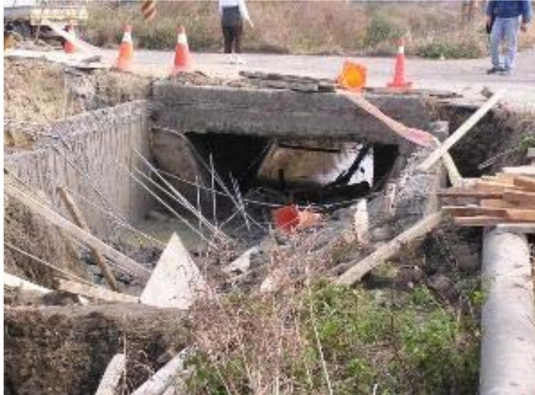
圖 31 從事版橋拆模作業發生版橋崩塌災害
