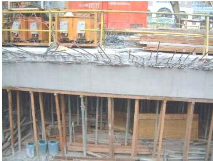
圖 103 鋼管與木支撐勁度不同混搭極易失效
