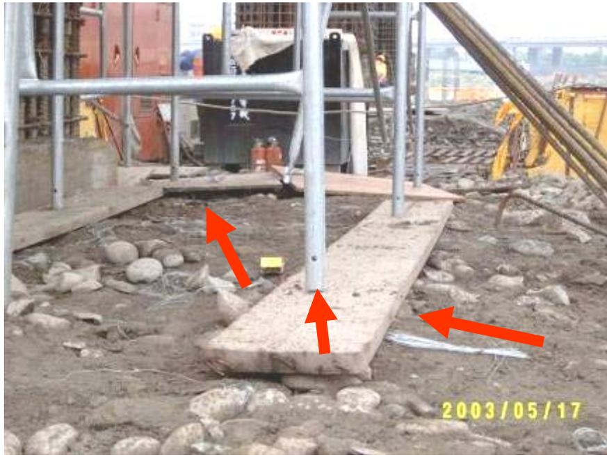
圖 76 支柱底部未適當固定，土壤未整平夯實
