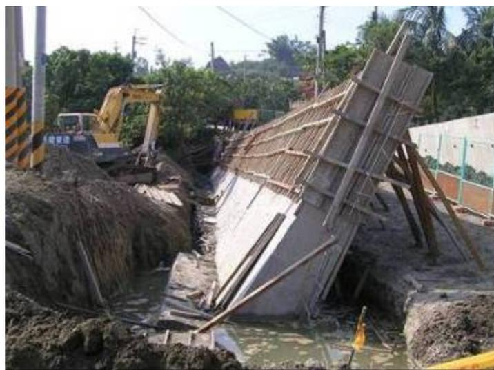
圖 25 從事擋土牆拆模作業發生擋土牆倒塌災害
