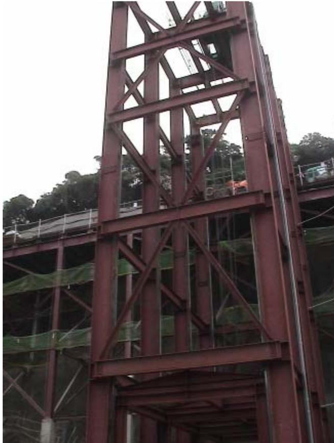
圖 155 以型鋼之組合鋼柱為模板支撐之支柱
