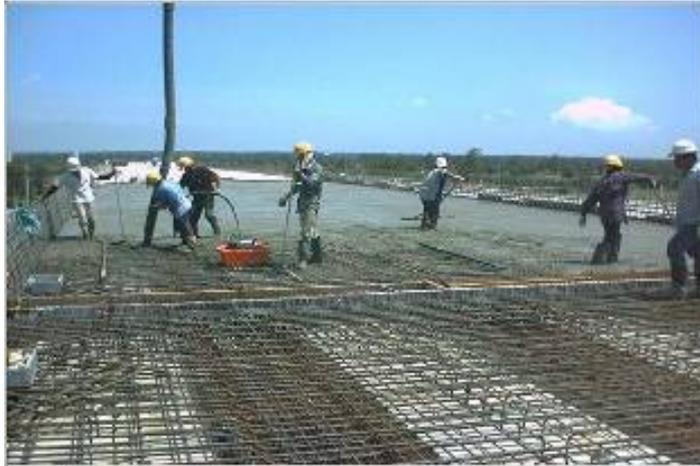
圖 65 混凝土澆置順序注意構造物受力平衡
