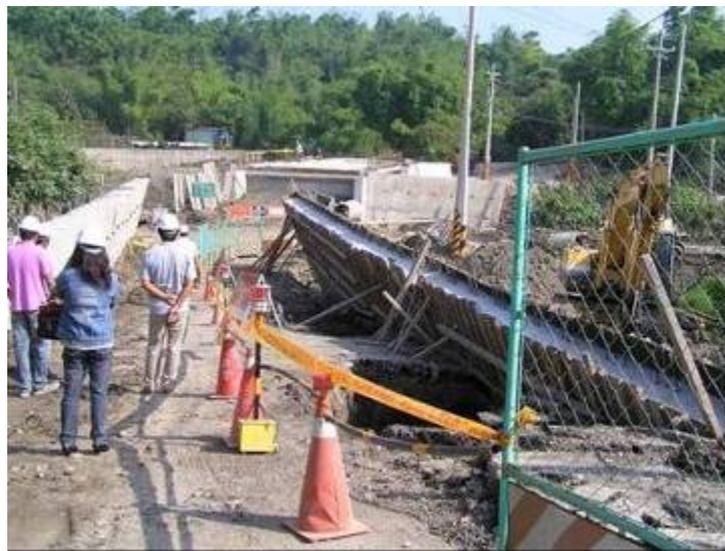
圖 24 災害發生之擋土牆倒塌處
