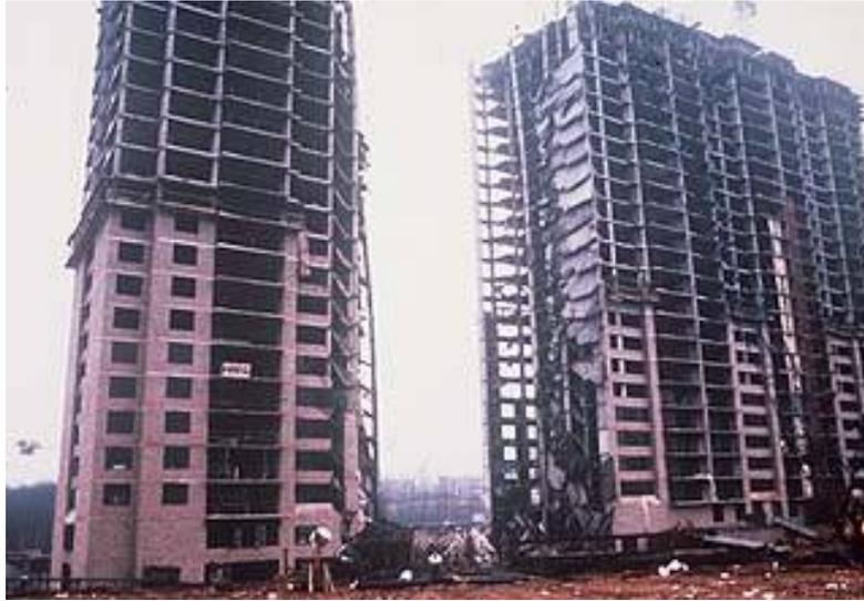
圖 45 模板支撐過早拆除導致崩塌
