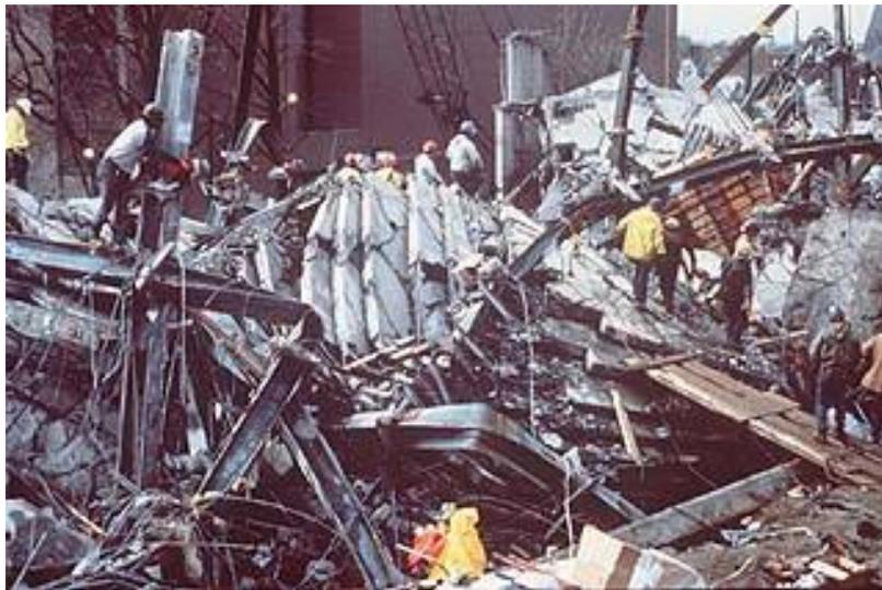
圖 43 模板支撐接頭強度不足造成倒塌
