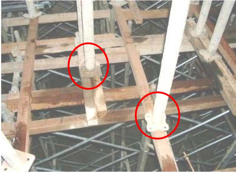
圖 102 鋼管支撐未座落於框式施工架支柱上
