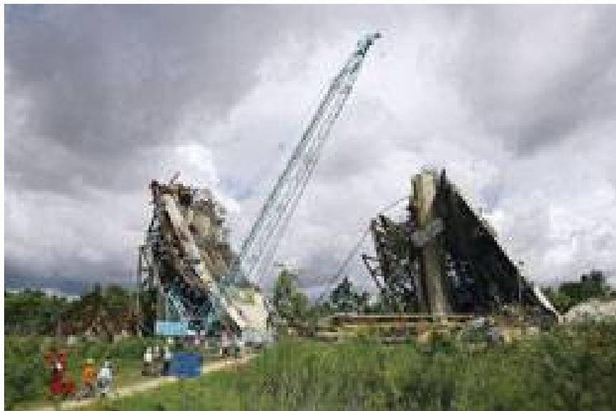
圖 41 基礎支撐力不足造成倒塌
