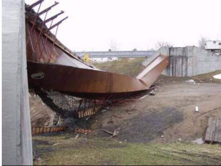
圖 42 人行陸橋於澆置混凝土時崩塌
