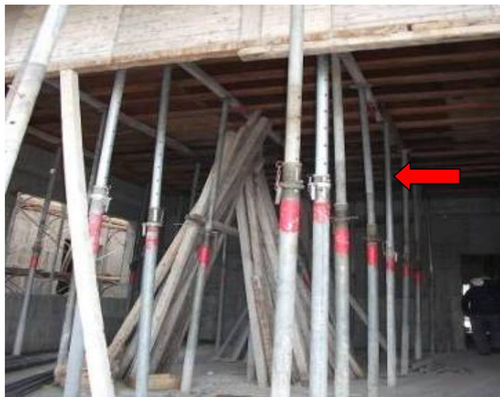
圖 69 可調式鋼管支撐已變形
