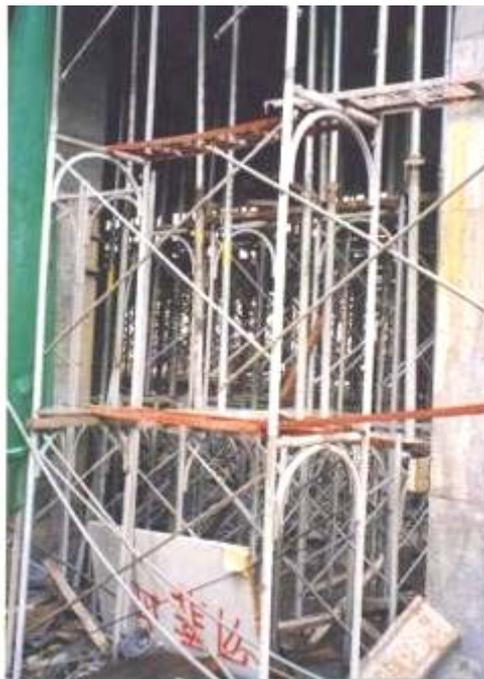
圖 95 複合式組搭水平貫材及接頭穩固性不足
