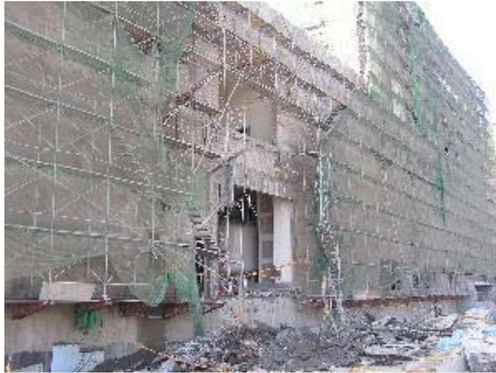
圖 30 勞工下工途中卸貨平台及模板支撐架倒塌
