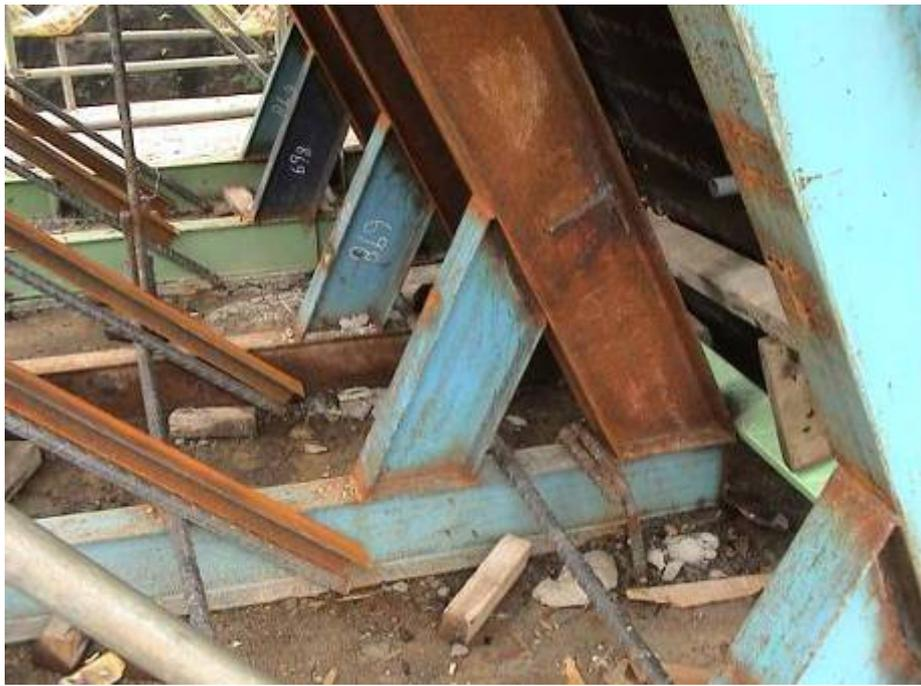
圖 166 以銲接方式固定
