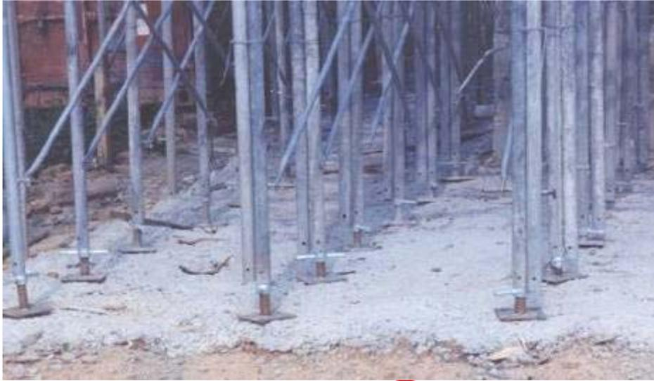
圖 128 鋼管施工架底部使用高低調整器及打設混凝土以防沉陷
