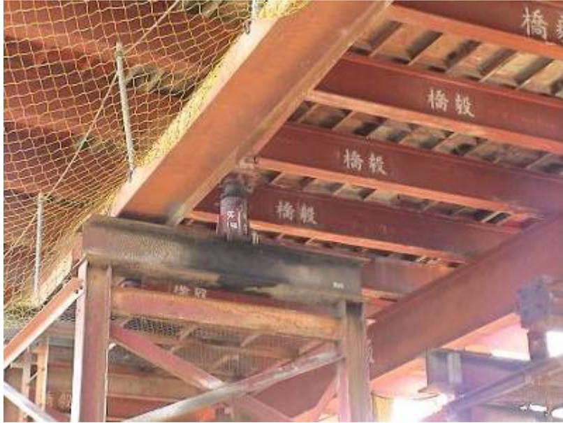
圖 148 上端設置梁式格柵時裝設鋼製之端板於頂端並固定於梁式格柵
