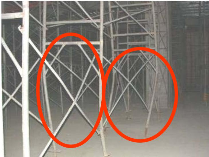
圖 68 鋼管施工架已變形
