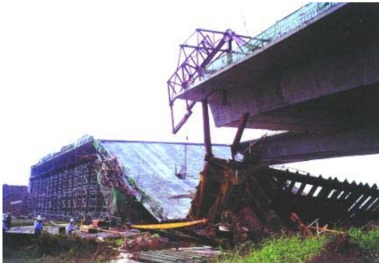
圖 33 現場撐橋樑倒塌情形
