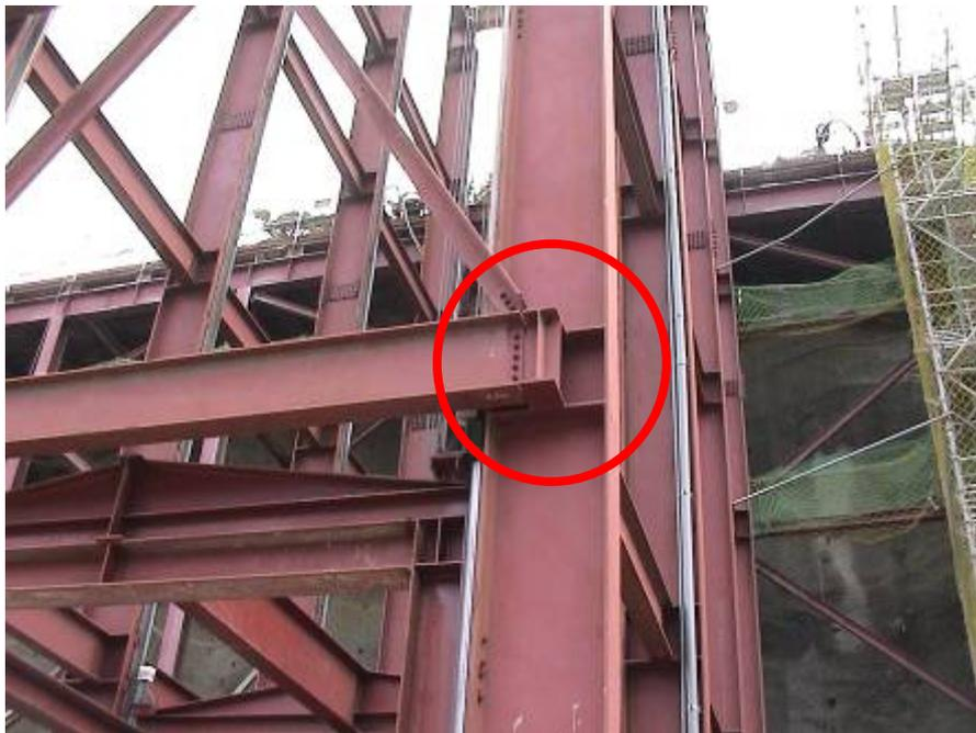
圖 156 接頭螺栓數量足夠，且確實鎖緊
