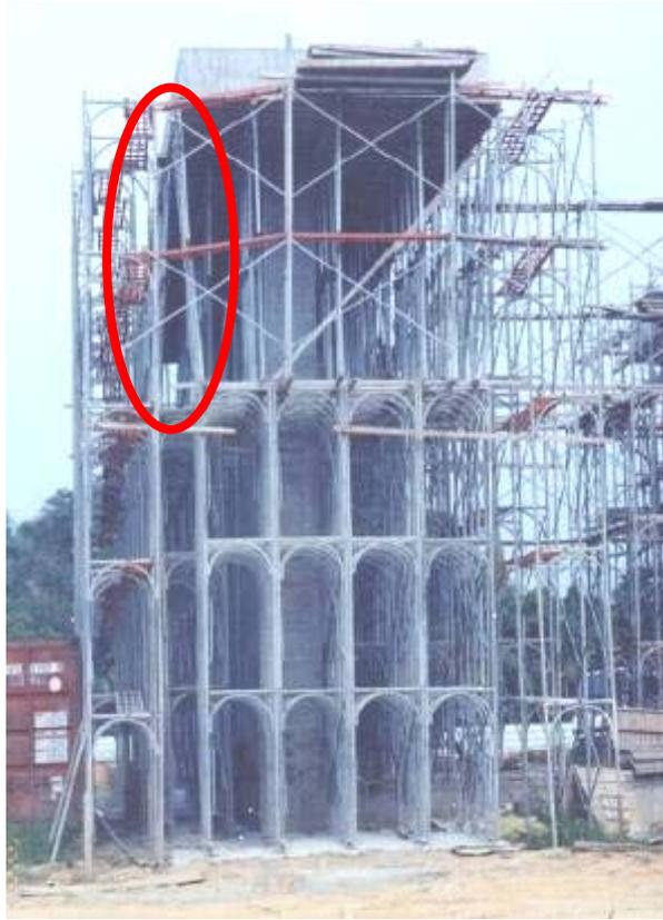
圖 92 框式施工架上方架設可調鋼管支柱
