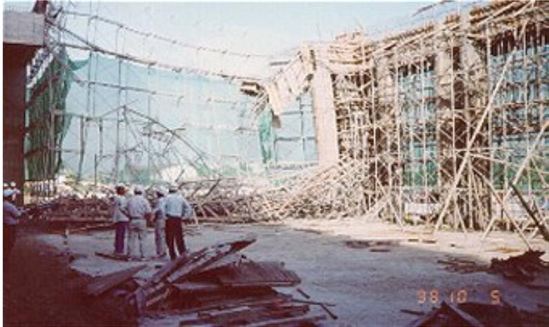
圖 36 模板支撐倒塌情形
