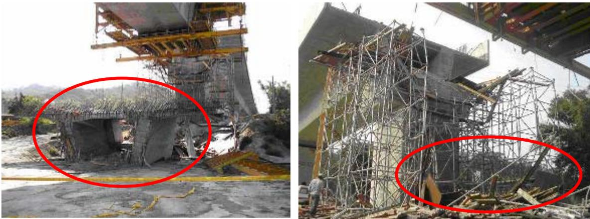
圖 32 預力混凝土橋梁因支撐架過早拆除致崩塌
