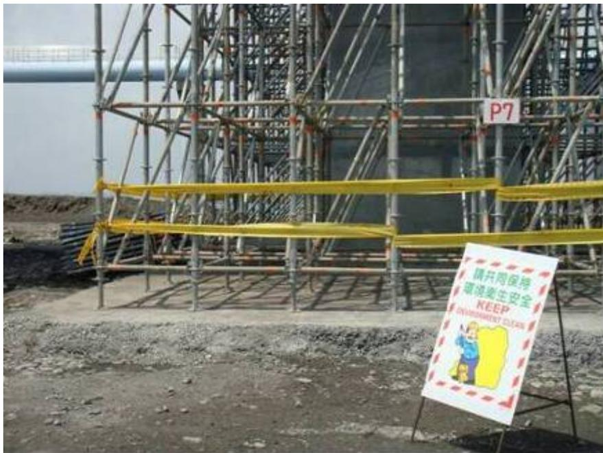
圖 131 原本礫石料基礎滾壓夯實並澆置 20~30 cm 無筋混凝土
