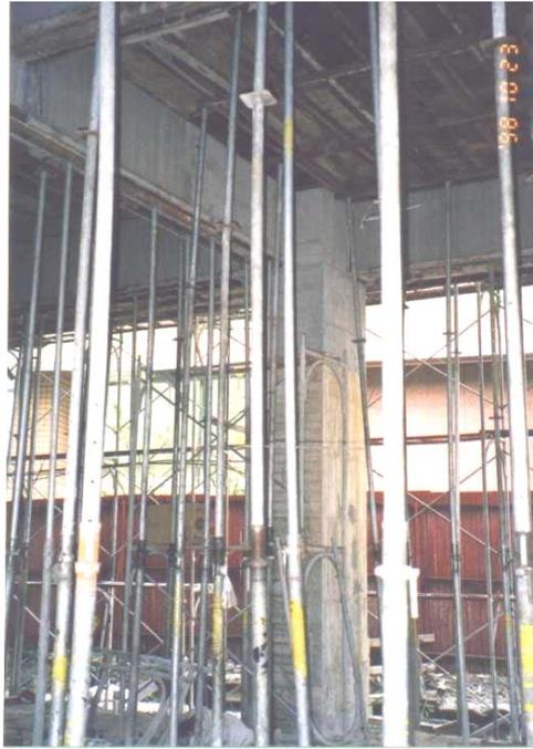
圖 89 可調式鋼管支撐架內木加水平繫條
