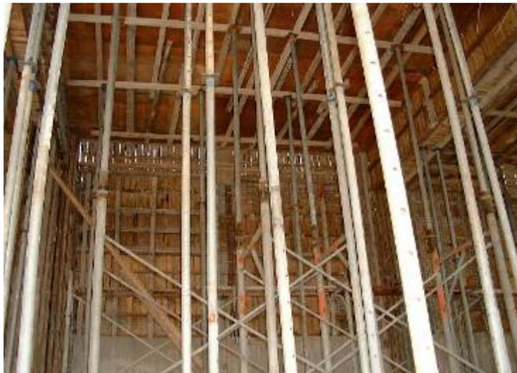
圖 88 高度超過 3.5 公尺以上可調式鋼管支撐未加水平繫條
