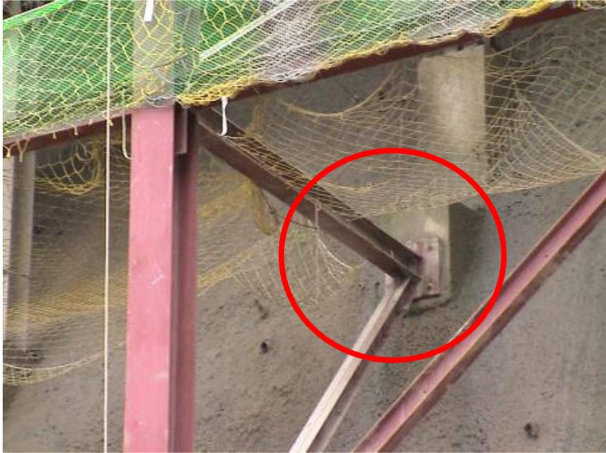
圖 162 水平橫樑固定於混凝土基礎，此混凝土基礎屬假設工程八、調整層
