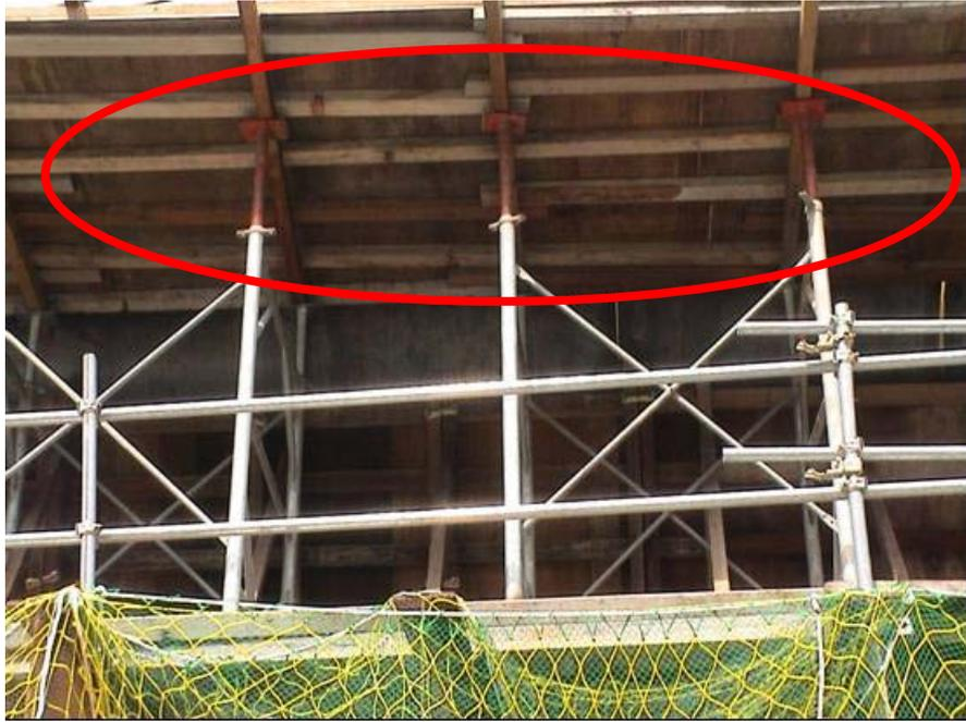
圖 160 上端支以樑或軌枕等貫材時，設置鋼製頂板，並固定於貫材
