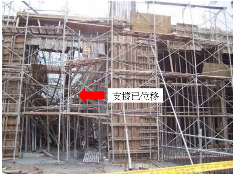
圖 27 雙層式鋼管支撐組搭，已產生位移
