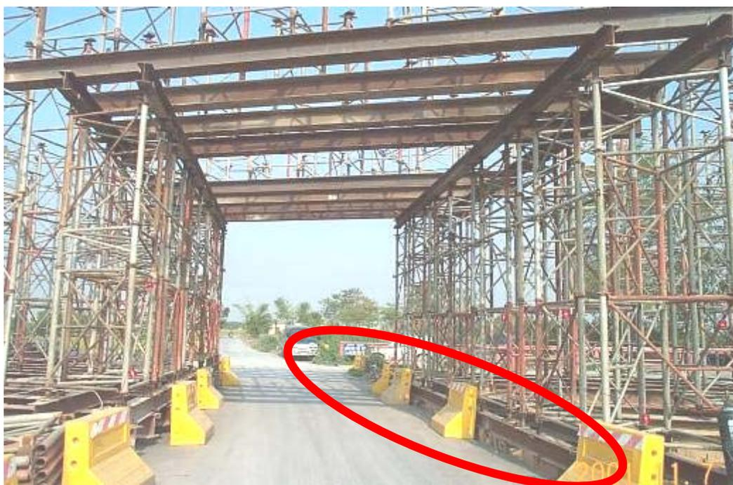
圖 133 基腳固定牢固並防止車輛撞擊
