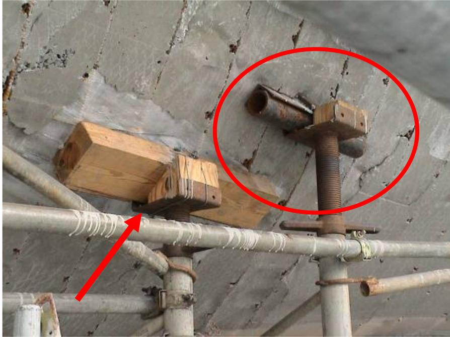
圖 169 以楔木調整或以鋼管、角鋼及木塊調整及固定
