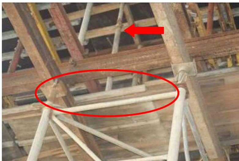
圖 99 架設高度較高時以多層方式架設使穩固性差
