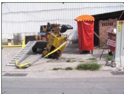
道板應充分穩固固定夯實機翻覆！
