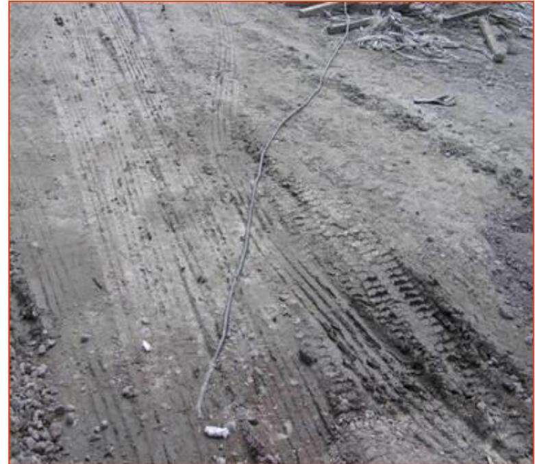
電氣線路未依規定架高或埋設，電氣絕緣易遭破壞而造成活電裸露，工作環境形成有感電危害，勞工作業中或通行中有感電危險
