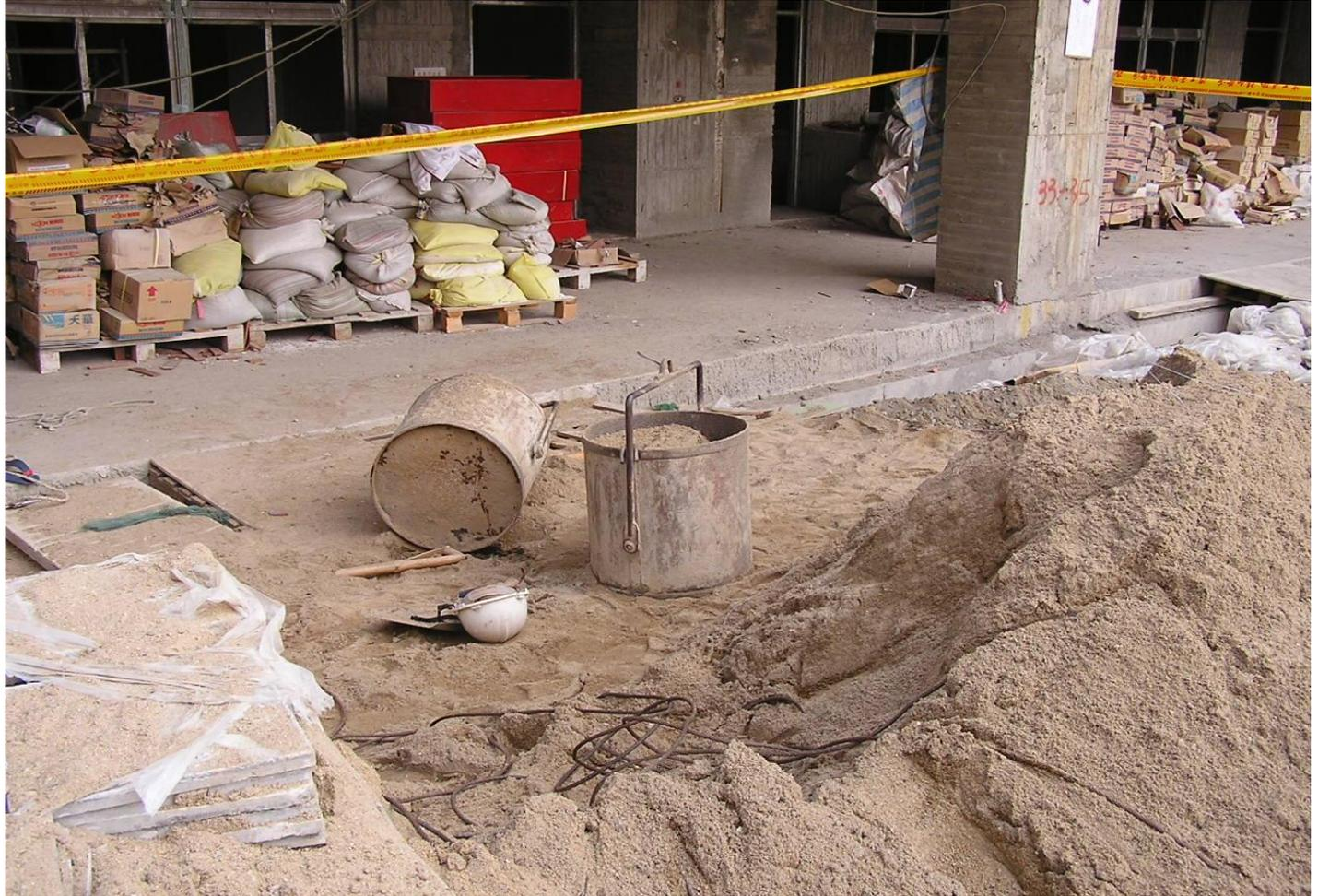
從事捲揚機吊運砂土時發生勞工被壓致死
