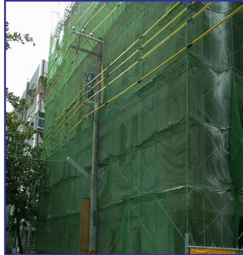
高壓線路依規定已採取將高壓活線以絕緣套管包覆，可避免安全距離或碰觸性
