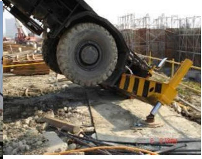
案例2：吊車吊裝角度過低及過重導致吊車翻覆等情況發生
