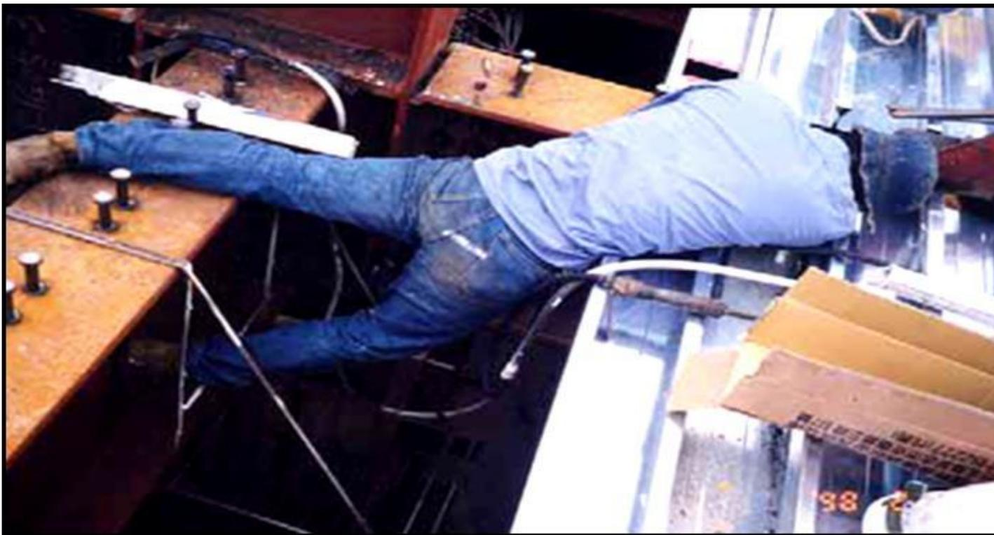
以交流電焊機於鋼構上從事電焊作業發生感電死亡
