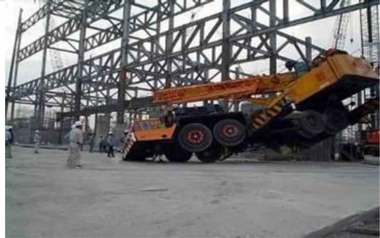
案例1：地面土質流失導致吊車支撐腳架貫穿地面而造成吊車翻覆
