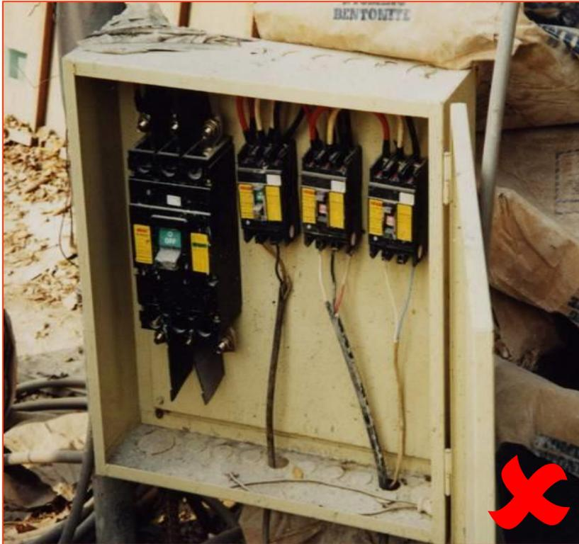
工地內攜帶式或移動式電動機具用電分路，未依規定設置高感度、高速型之漏電斷路器
