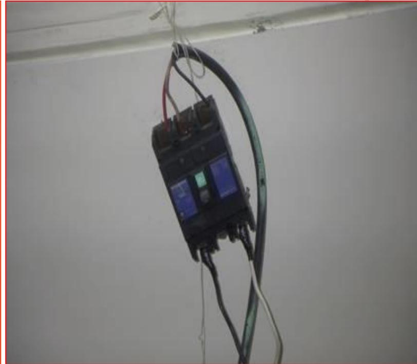
電氣開關未依規定設置防止感電之箱體護圍隔離，工作環境形成有感電危害，勞工作業中有感電危險
