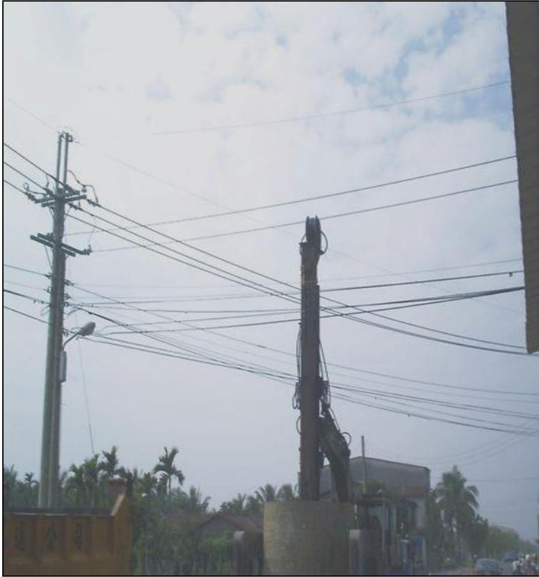
於接近高壓線路附近從事移動式起重機吊掛作業，未採取將高壓活線以絕緣套管包覆，防止作業中安全距離不足
