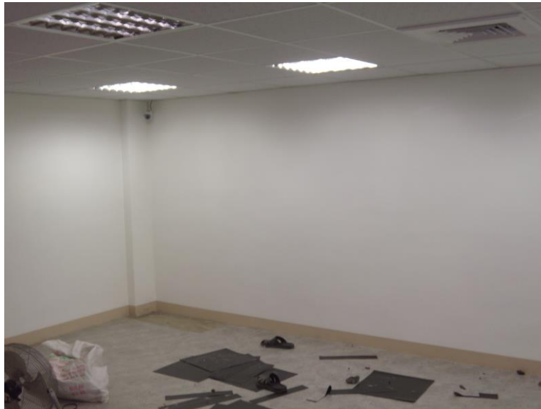
事故現場地下室
