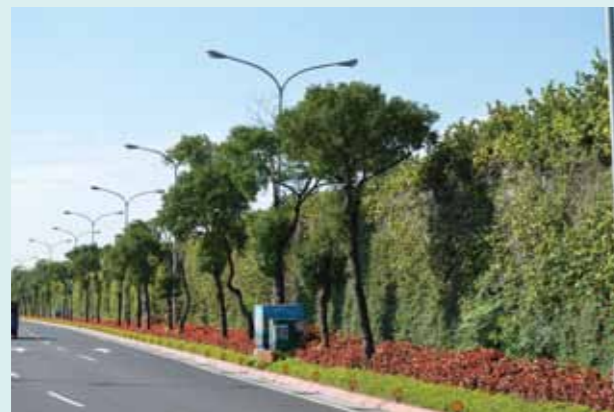
大漢溪右岸板橋堤防，植栽行道樹及爬藤植物綠美化，讓灰冷防洪牆憑添繽紛色彩
