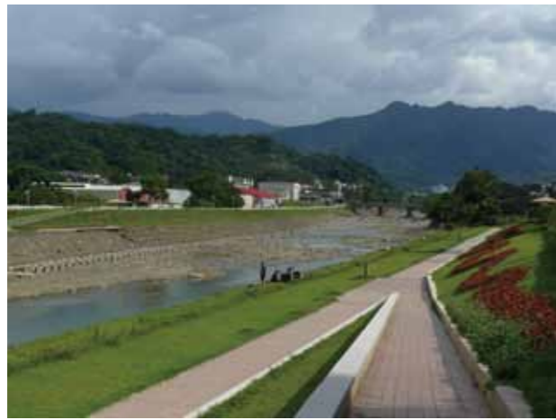
三峽河河堤綠帶，防洪又具景觀-長福橋段河岸
