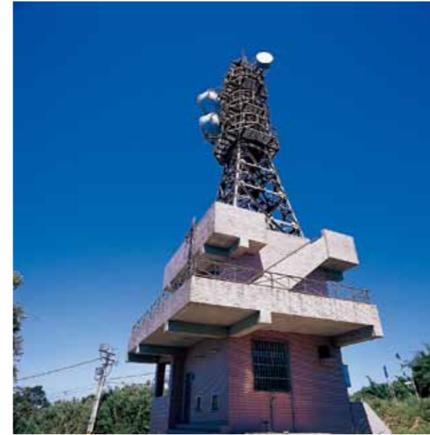
大棟山微波中繼站
