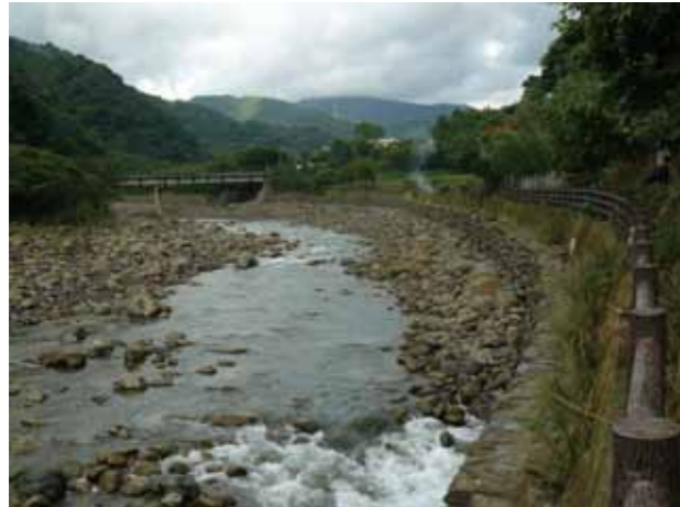
三峽河河堤綠帶，防洪又具景觀-金龍橋段河岸
