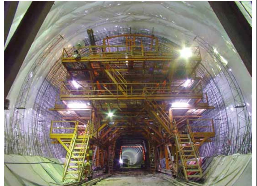
員山子分洪工程隧道內，施工情形
