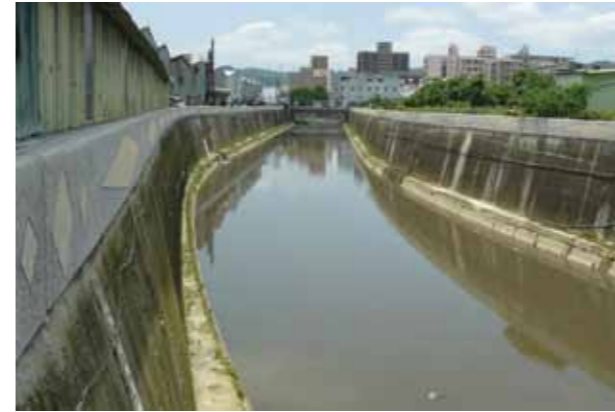
塔寮坑溪堤防加高工程
