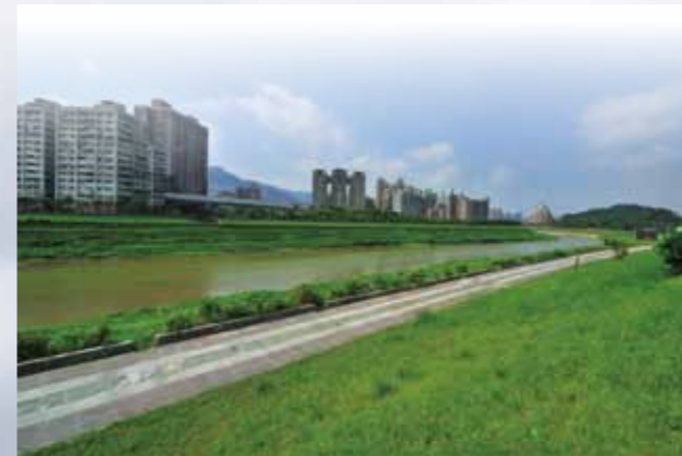
基隆河汐止橋東堤防
