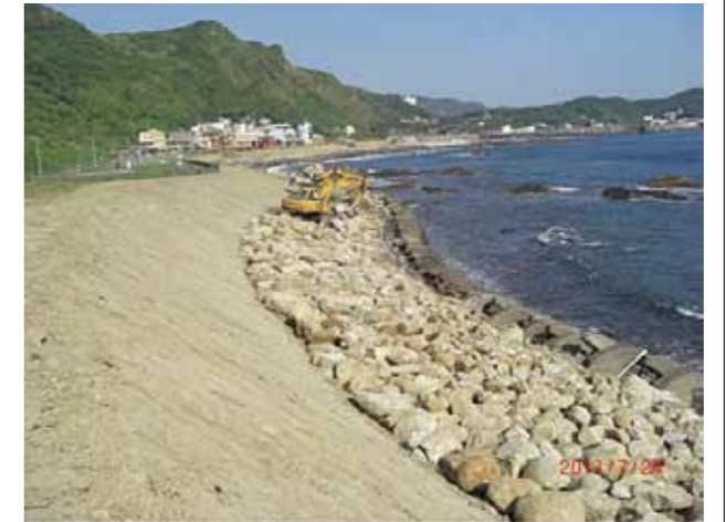
榮興海岸位於臺灣東北角新北市瑞芳區，近年施工以保護邊坡為主，避免海浪長期淘刷裸露崩塌，以拋塊石回復自然海岸景觀；與當地環境融合，並改善整體海岸景觀。
