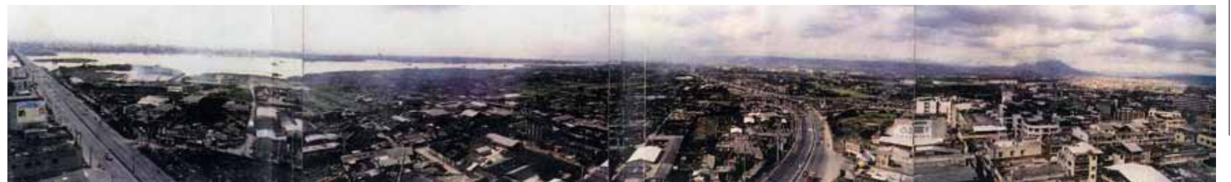
二重疏洪道施工中
