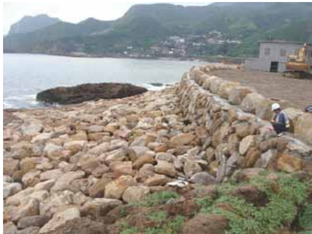
瑞芳洞頂以拋塊石工法保護海堤
