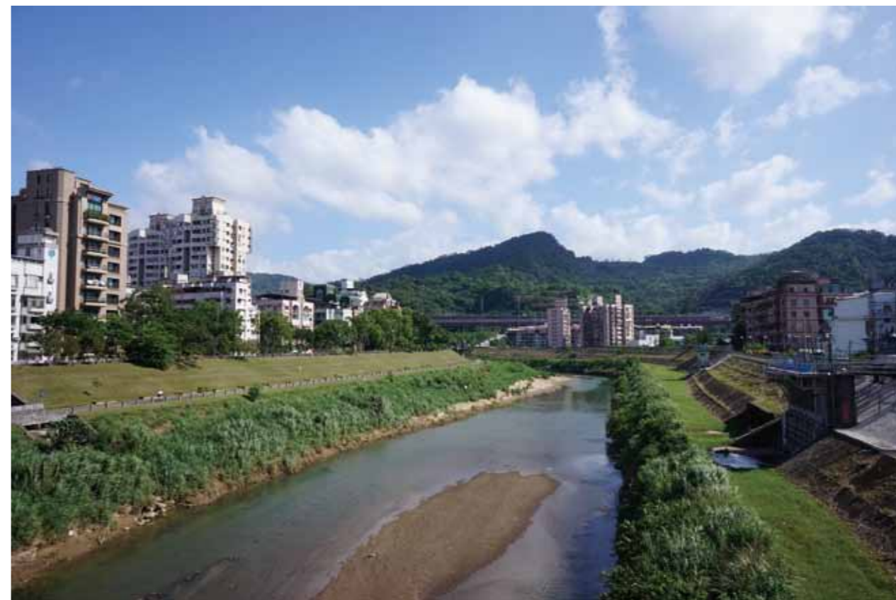
景美溪整治採生態工法，保留原生植物，再輔以植栽，經過洪水洗禮後的景美溪，綠波逐流，好不美麗
