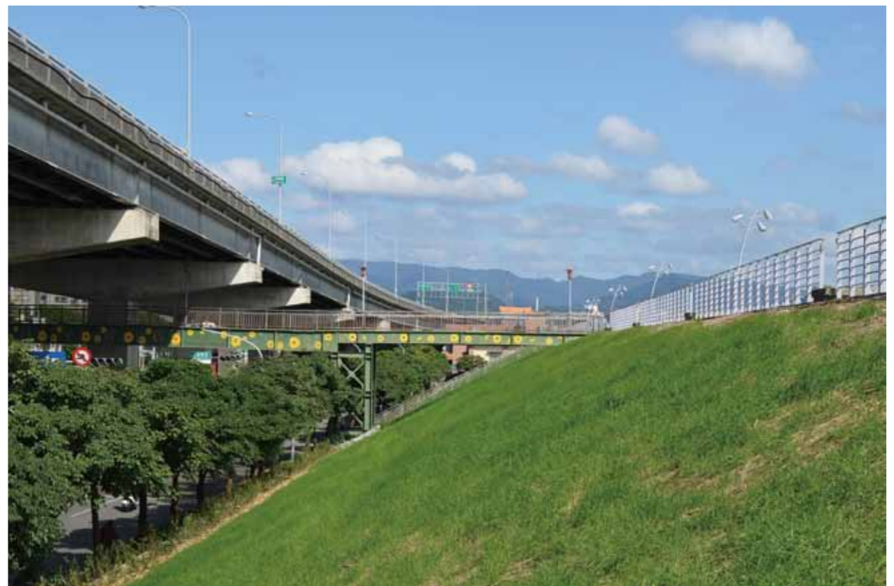
淡水河新北市三重區沿岸，堤防外是忠孝碼頭，堤防內土堤植栽綠美化，土堤上寬敞的步道，防洪又休閒
