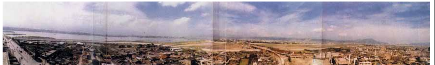
二重疏洪道施工前
