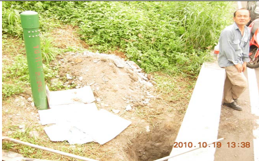
99.10.19 高雄市大寮區高屏溪大寮堤防 7K+000 旁邊坡擅自變更河防構造物
