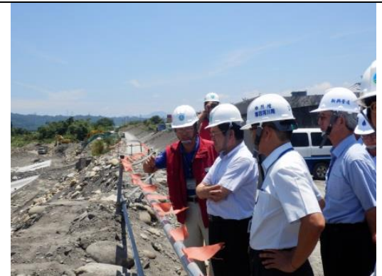
6-楊署長視察南投縣竹山鎮濁水溪水底寮堤防復建工程了解施作進度及情形。
