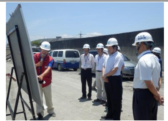
5-楊署長視察南投縣竹山鎮濁水溪水底寮堤防復建工程聽取王正工程司洪明簡報。
