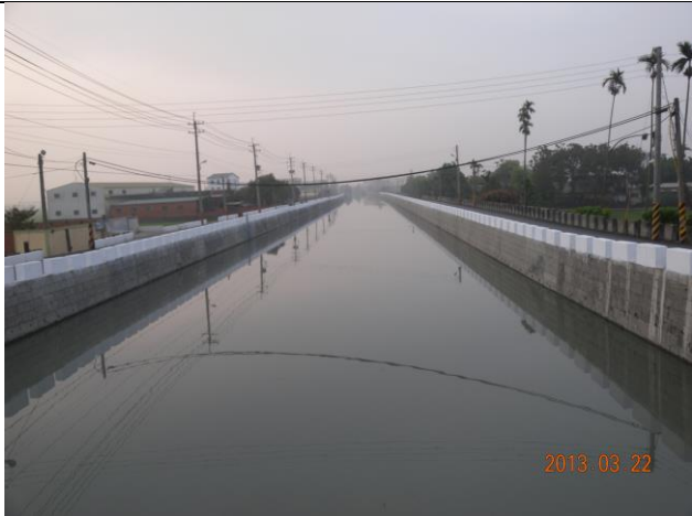
5. 監察委員現地考察—石筍排水整治現況
