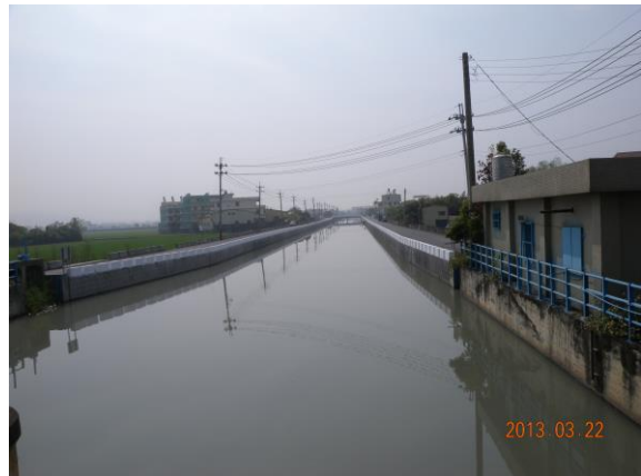
6. 監察委員現地考察—石筍排水整治現況。
