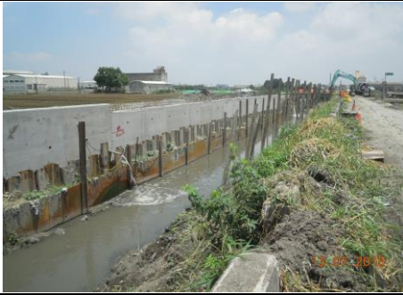
5-安東二排排水整治施工中現況
