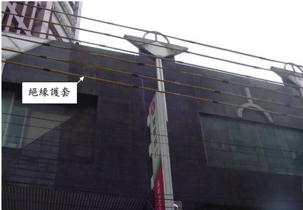
於接近電路或其支持物從事作業時，應於該電路裝置絕緣護套等絕緣用防護裝備。
