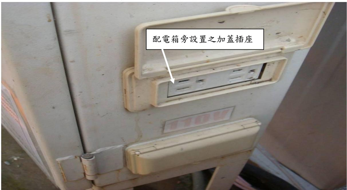
配（分）電箱旁外部設置加蓋之插座孔裝設 110V 之插座。
