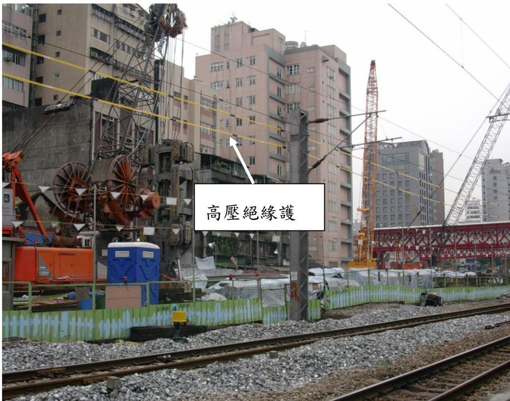
接近高壓電線作業應事先加裝絕緣護套等防護。
