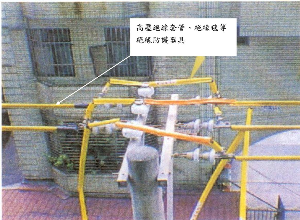
接近高壓架空電線之場所從事作業時，應使勞工使用電工安全帽、絕緣防護器具及其他防護器具。利用設有具絕緣升降桶設備之高空工作車，並於電路四周裝置絕緣用防護裝備。
