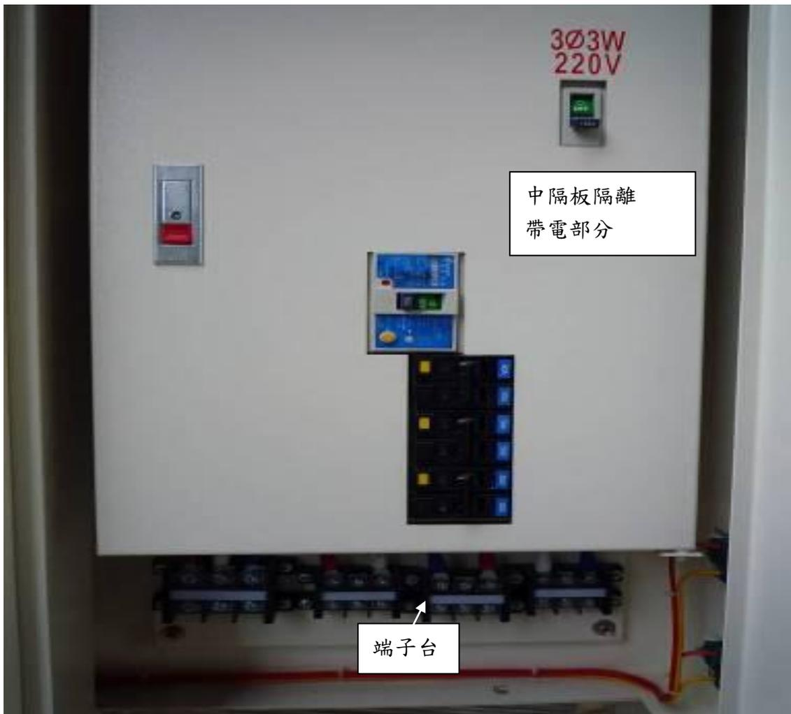
配(分)電盤、箱設置中隔板隔離開關帶電部分，下方專設端子台，供分路接線使用。
