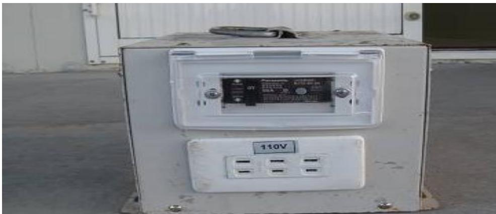
臨時用電分路設置漏電斷路器，防止感電事故。
