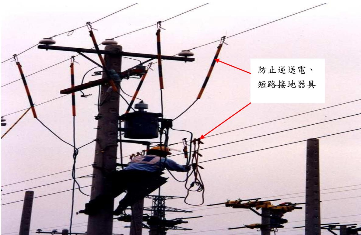
當電路開路後，以檢電器具檢查確認已停電，並消除殘餘電荷。為防止與其他電路混觸、感應或逆送等感電危害，應使用短路接地器具，確實使線路短路及加設接地。
