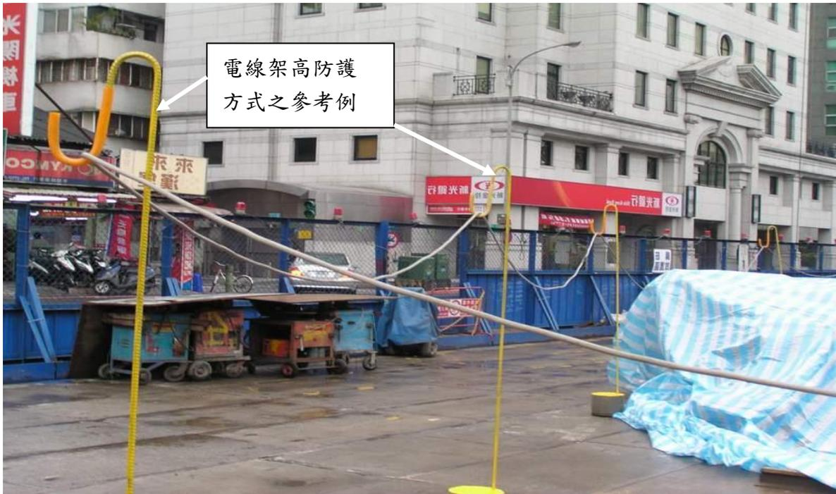
電線架高避免因地面積水導致電線浸水，受外力破壞絕緣而漏電。
