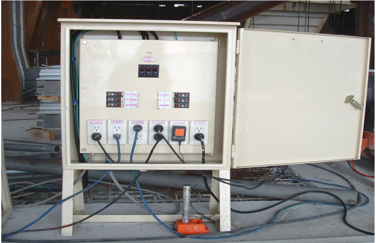
臨時用電所使用之配（分）電箱設置箱、蓋、中隔板等防止人員誤觸帶電部分。
