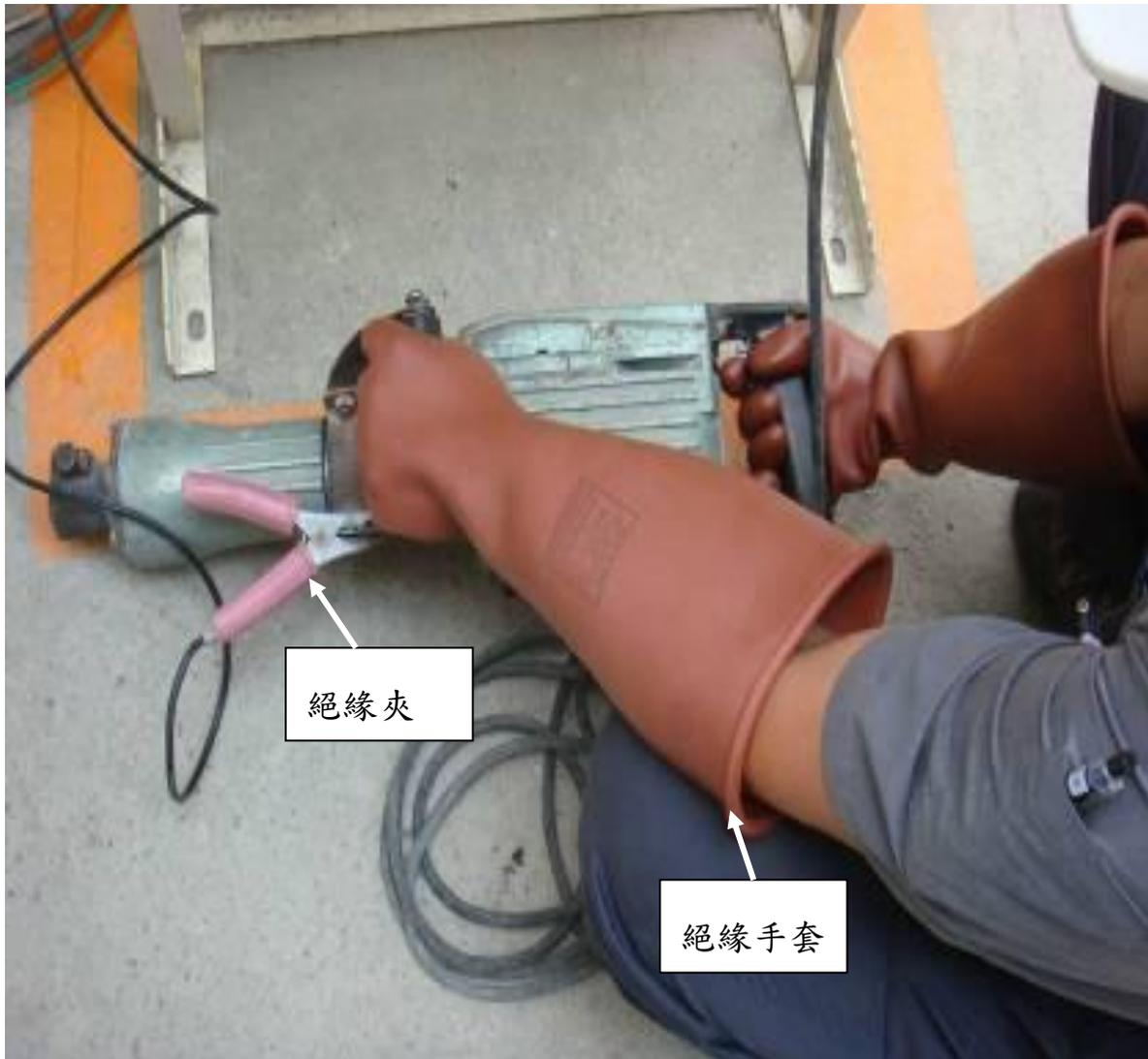
本照片為活線作業測試電動機具金屬外殼是否帶電，利用測試儀表附絕緣套之探測夾夾持金屬外殼，測試儀表另一探測棒接觸電源，實施檢測作業，人員戴用絕緣手套。
