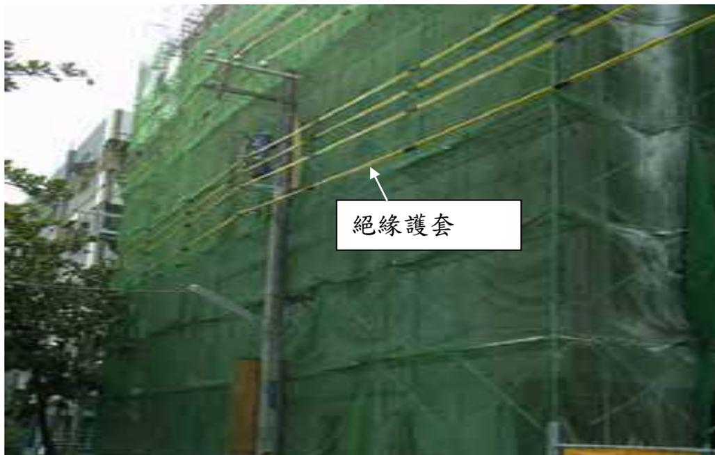
接近電路或其支持物從事敷設、檢查、油漆等作業時，應於該電路裝置絕緣護套等絕緣用防護裝備。
