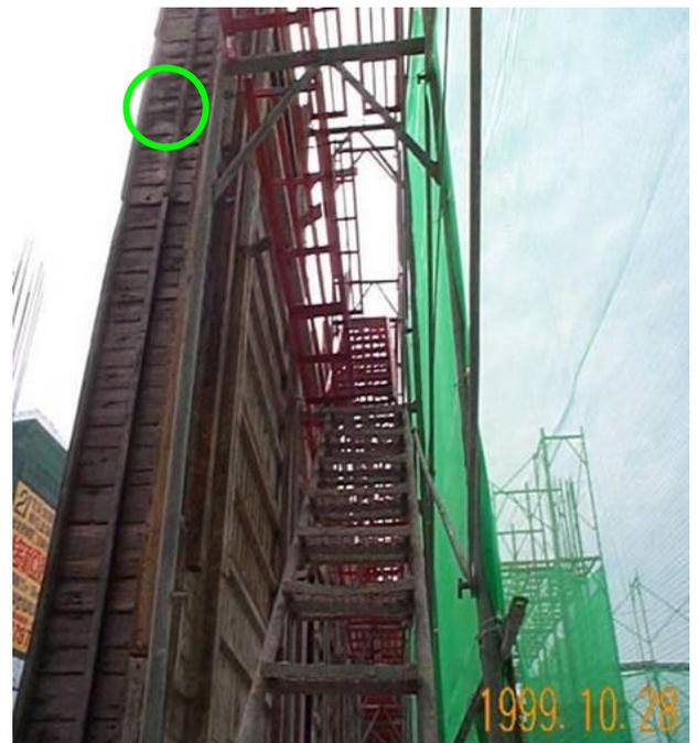
十一、電梯井施工構台組搭，勞工有遭受墜落危險之虞者，應於該處設置護欄、護蓋或安全網等防護設備。
