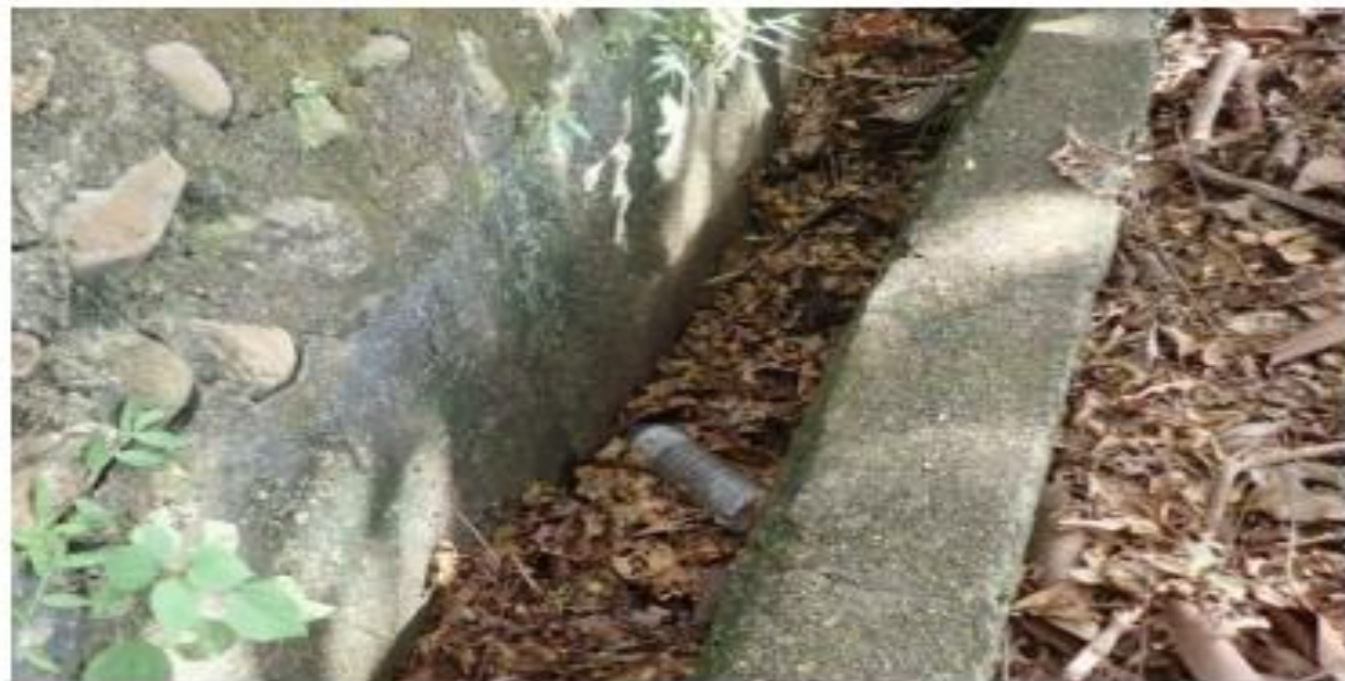
(b)水量少時被落葉阻塞之水溝狀況
