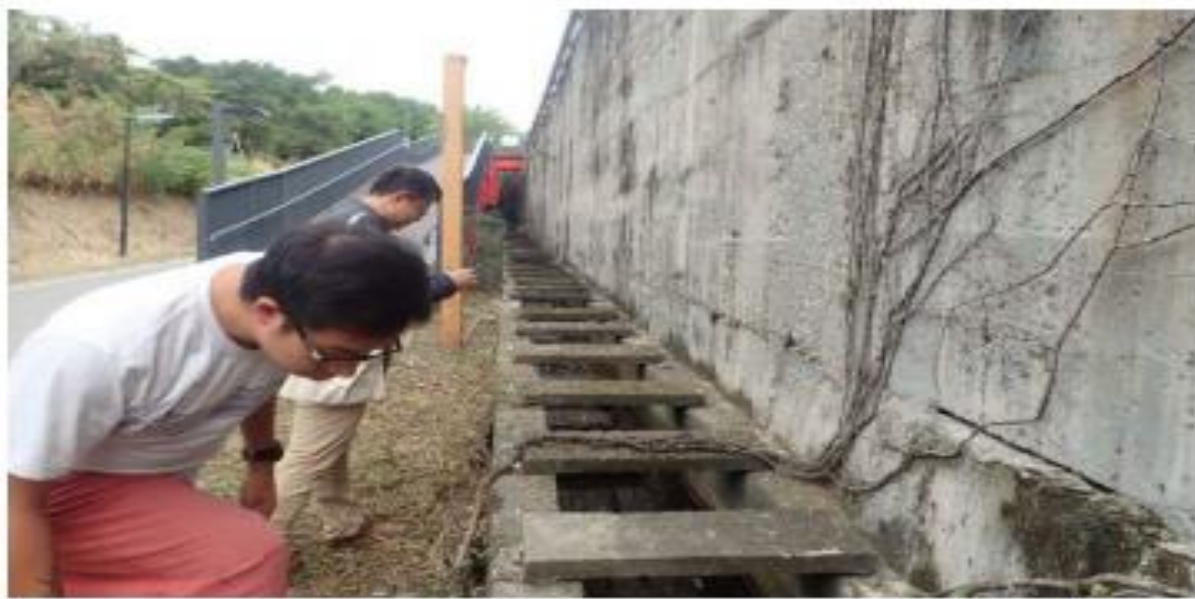
(b)花蓮港務公司與腳踏車道間排水溝
