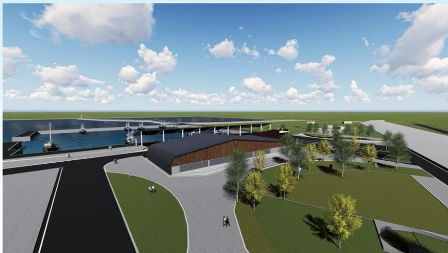
規劃36個攤位未來可供漁民彈性使用。在漁民漁業輔助設施方面，本工程新建一座半戶外整網場，寬約15公尺、長約90公尺挑高5至7公尺鋼棚式建物，內部規劃有天車設備，可供吊放漁網及漁獲運送作業，另有全戶外整網場，除可供漁民整補及曝曬漁網，藉由漁民作業情形，交織出在地漁村風情文化。
