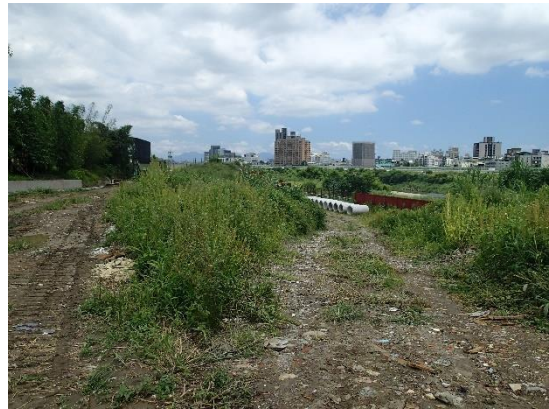
三峽河工程現勘 108/08/12
