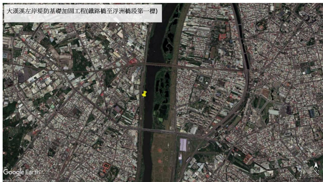
圖 3.1-1 大漢溪左岸堤防基礎加固工程(鐵路橋至浮洲橋第一標)
