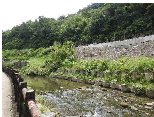
基隆河工程現勘 108/08/12
